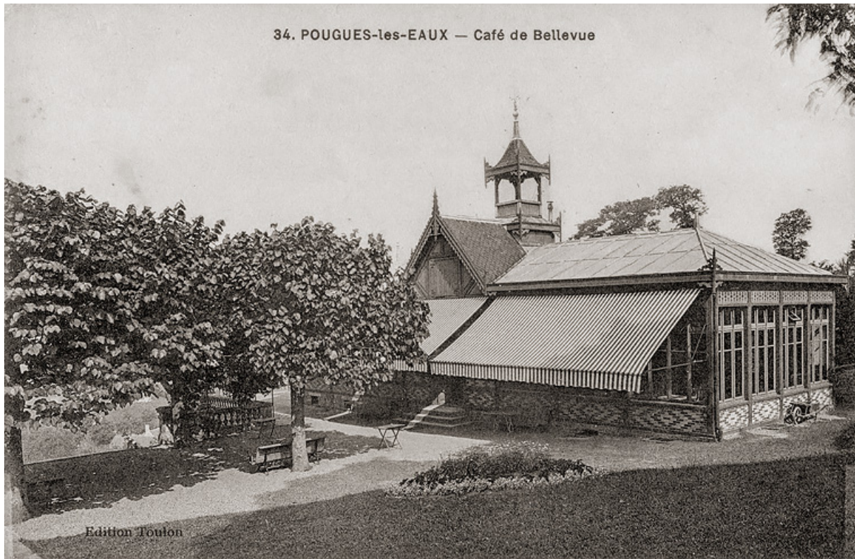
Café-restaurant à l'extrémité nord de la terrasse, vue depuis l'est. 58, Pougues-les-Eaux avenue de Paris, lieudit : Bellevue
