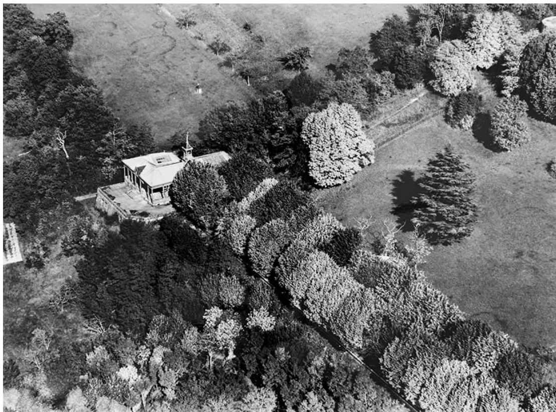
Café-restaurant à l'extrémité nord de la terrasse, photographie aérienne prise en 1958.
