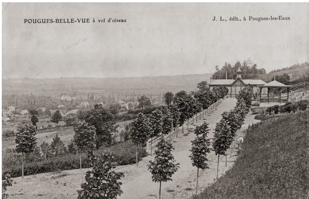
Allée de tilleuls sur la terrasse, vue d'ensemble avec le kiosque à musique et le café-restaurant. 58, Pougues-les-Eaux avenue de Paris, lieudit : Bellevue
