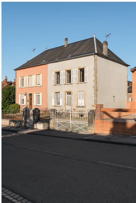
Façade sur l'actuelle avenue Eugène Collin.
