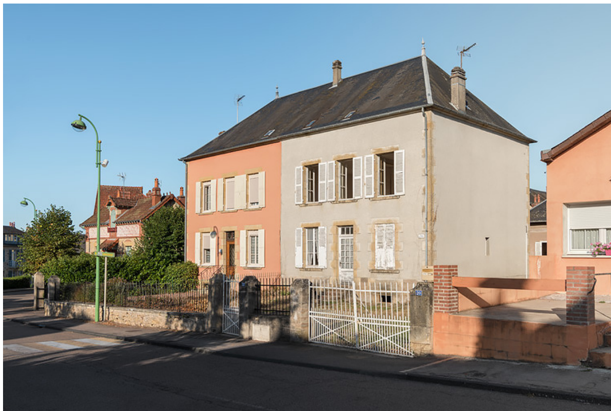
Façade sur l'actuelle avenue Eugène Collin.
