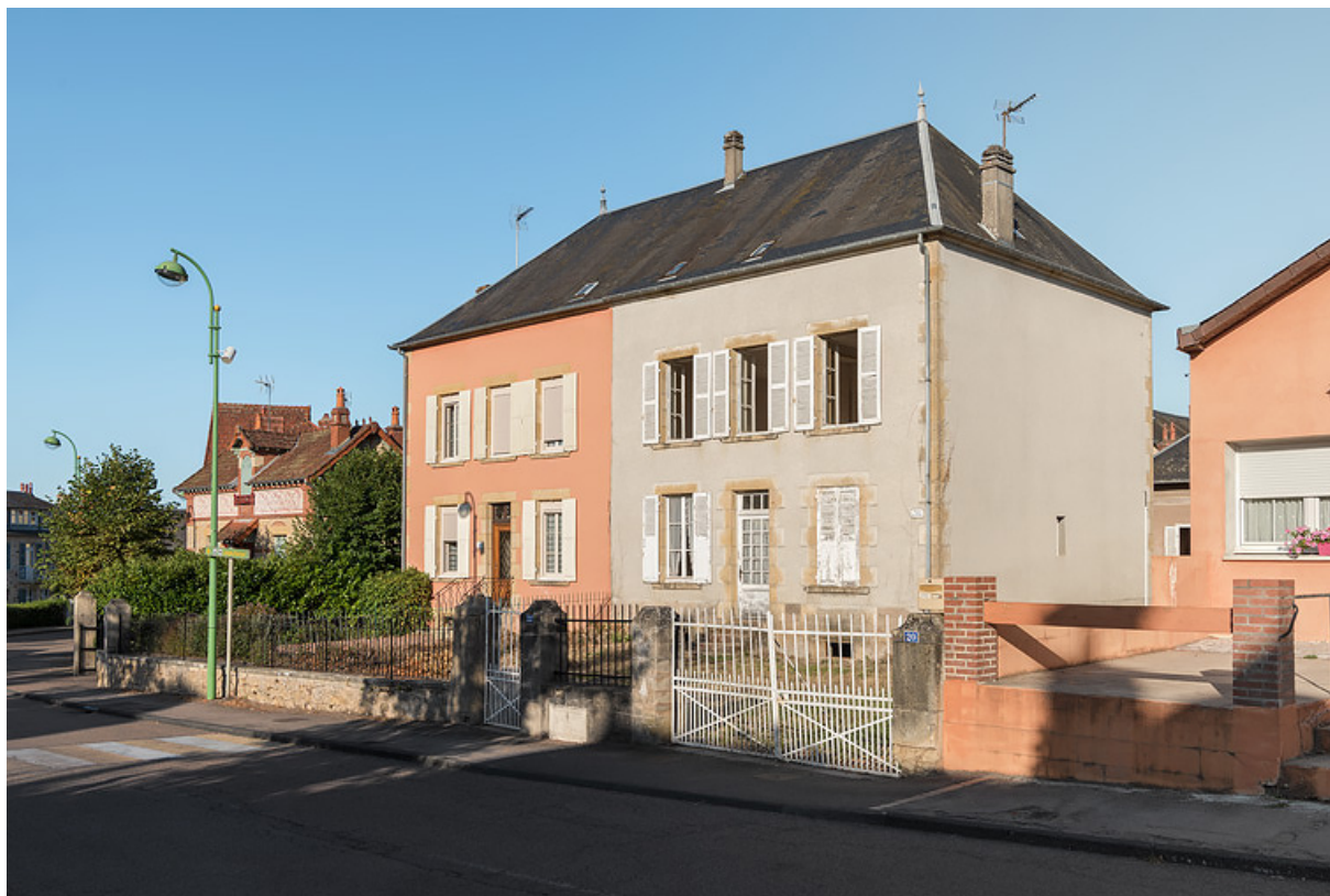
Façade sur l'actuelle avenue Eugène Collin.
