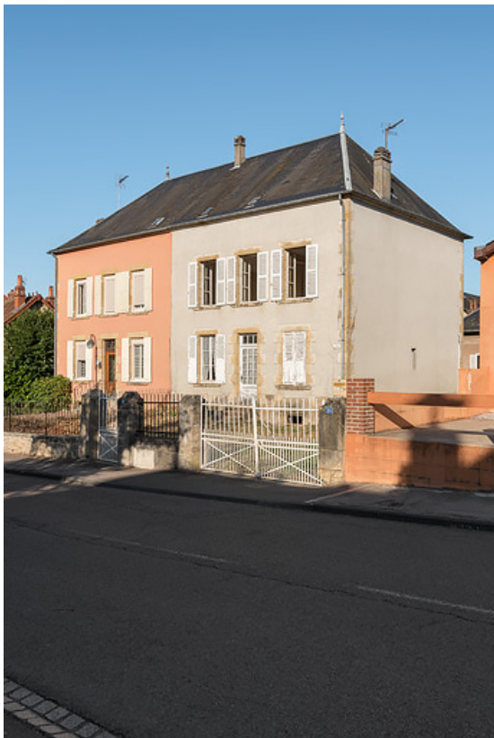
Façade sur l'actuelle avenue Eugène Collin.
