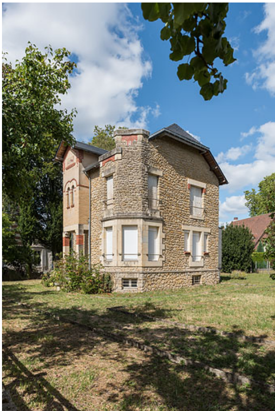
Vue depuis le sud-ouest.
