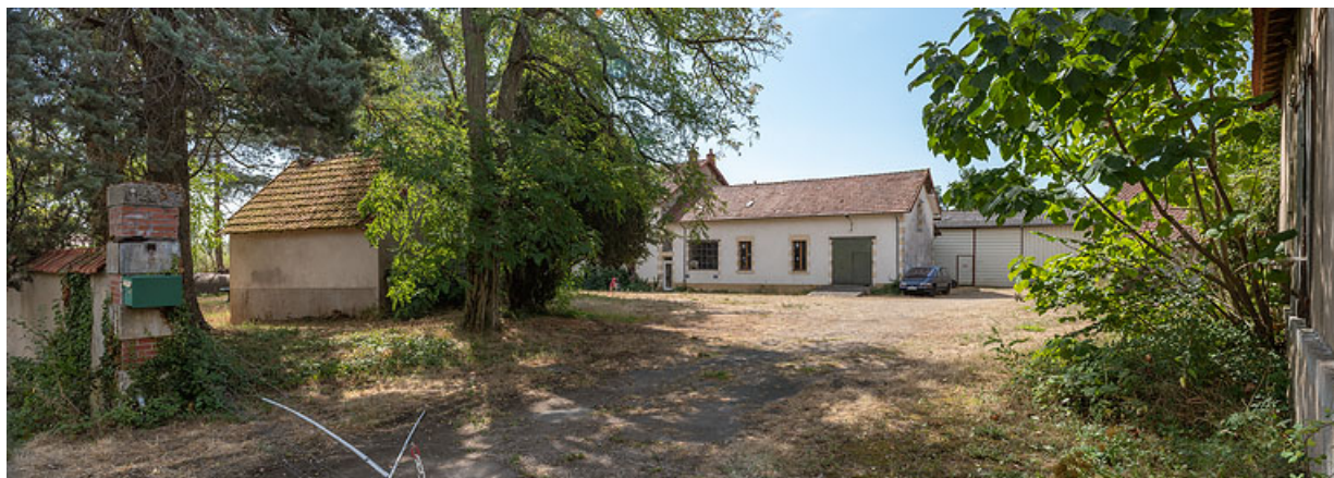
Usine de mise en bouteilles (au fond), bureau (à gauche) et dépendance (à droite). 58, Saint-Parize-le-Châtel, 22 rue des Fonts-Bouillants
