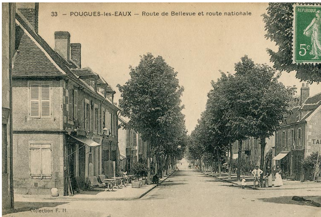
Avenue de Paris, vue en direction du nord, croisement avec la rue du Docteur Jean Pidoux, dans les années 1910. 58, Pougues-les-Eaux
