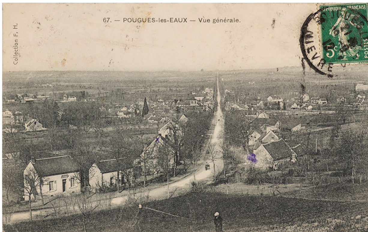
Avenue de Paris, vue en direction du nord depuis le site de Bellevue, dans les années 1910.
