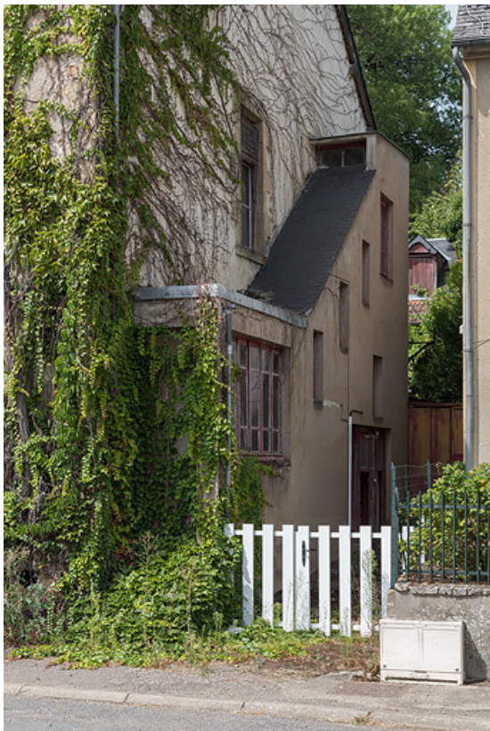
Escalier droit hors-œuvre construit contre le pignon nord permettant d'accéder à l'étage. 58, Saint-Honoré-les-Bains, 20 ter rue des Caves
