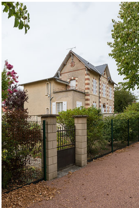
Vue de trois-quarts, depuis l'avenue du Casino.
