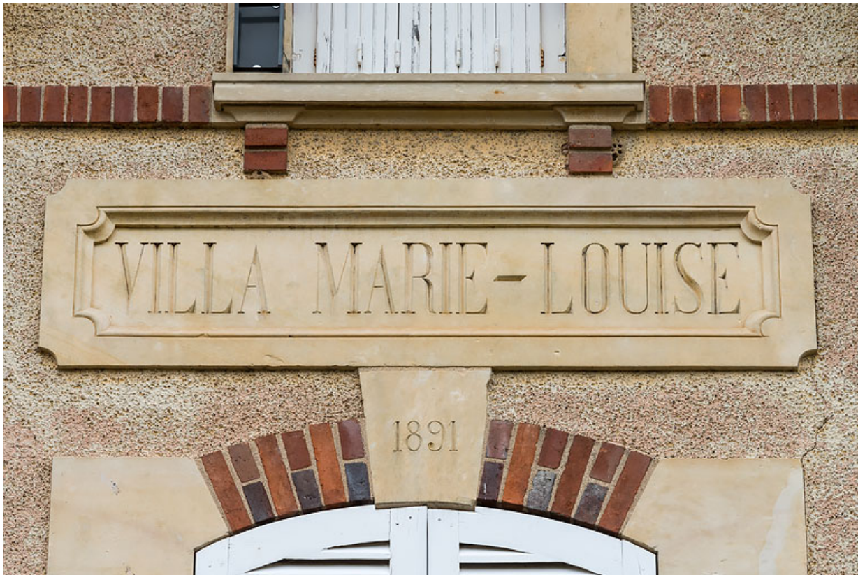
Avant-corps de la façade principale, inscription : "VILLA MARIE-LOUISE". 58, Pougues-les-Eaux, 6 avenue de Conti
