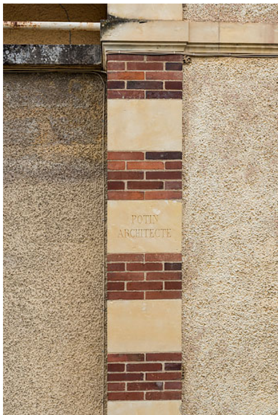
Ressaut gauche de l'avant-corps de la façade principale, signature : "POTIN ARCHITECTE". 58, Pougues-les-Eaux, 6 avenue de Conti
