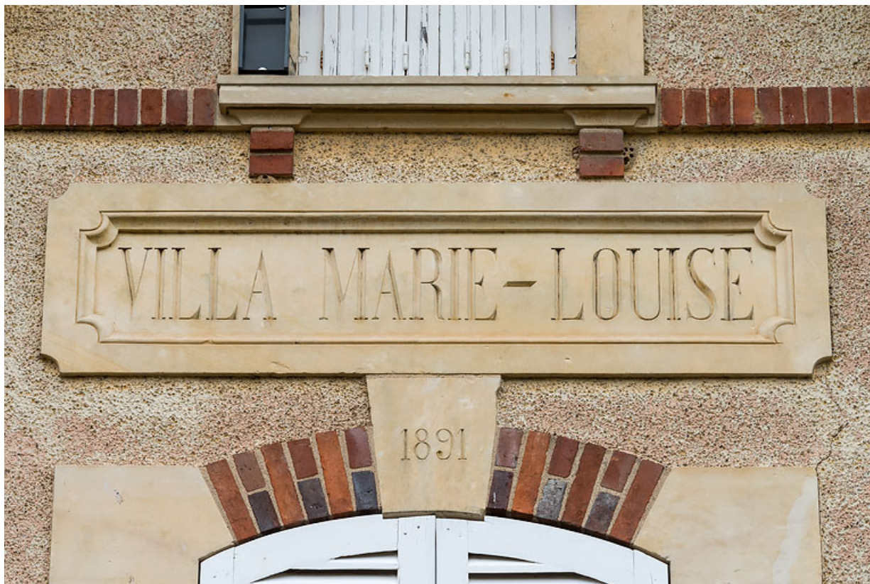
Avant-corps de la façade principale, inscription : "VILLA MARIE-LOUISE". 58, Pougues-les-Eaux, 6 avenue de Conti
