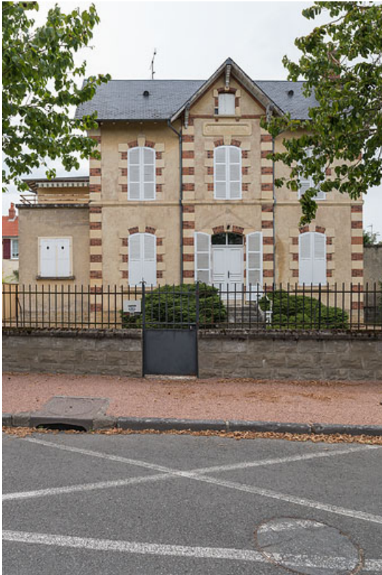
Vue de face, depuis l'avenue du Casino.
