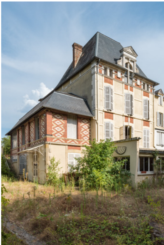
Élévation sur le jardin de la partie nord et de l'extension en brique. 58, Saint-Honoré-les-Bains, 47 avenue du Général d'Espeuilles
