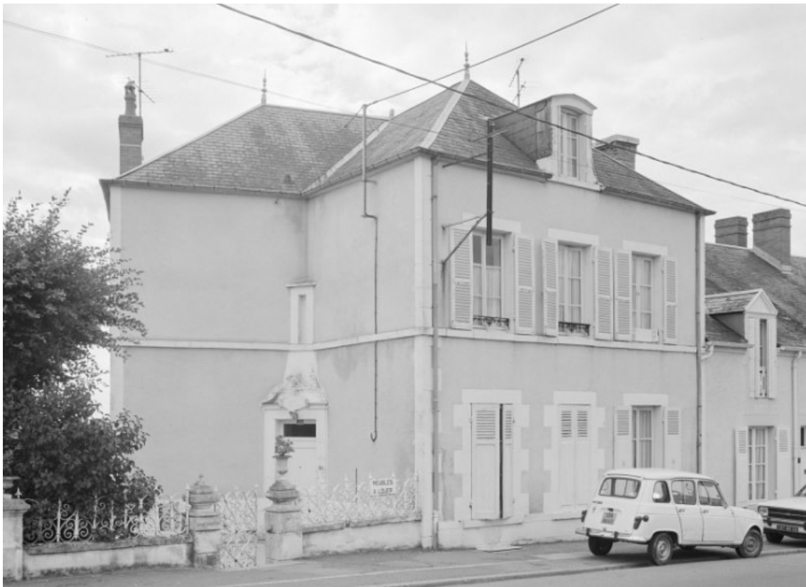
Élévation sur l'actuelle avenue du Général d'Espeuilles en 1978.
