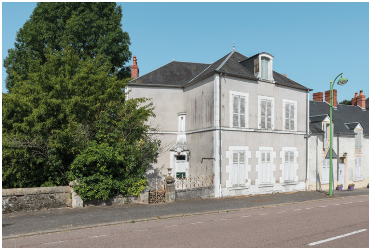
Élévation sur l'actuelle avenue du Général d'Espeuilles en 2019.
