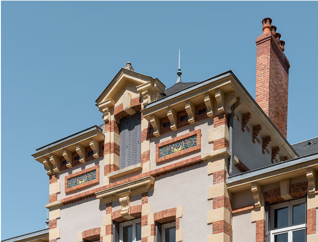
Avant-corps central de la façade principale, détail.
