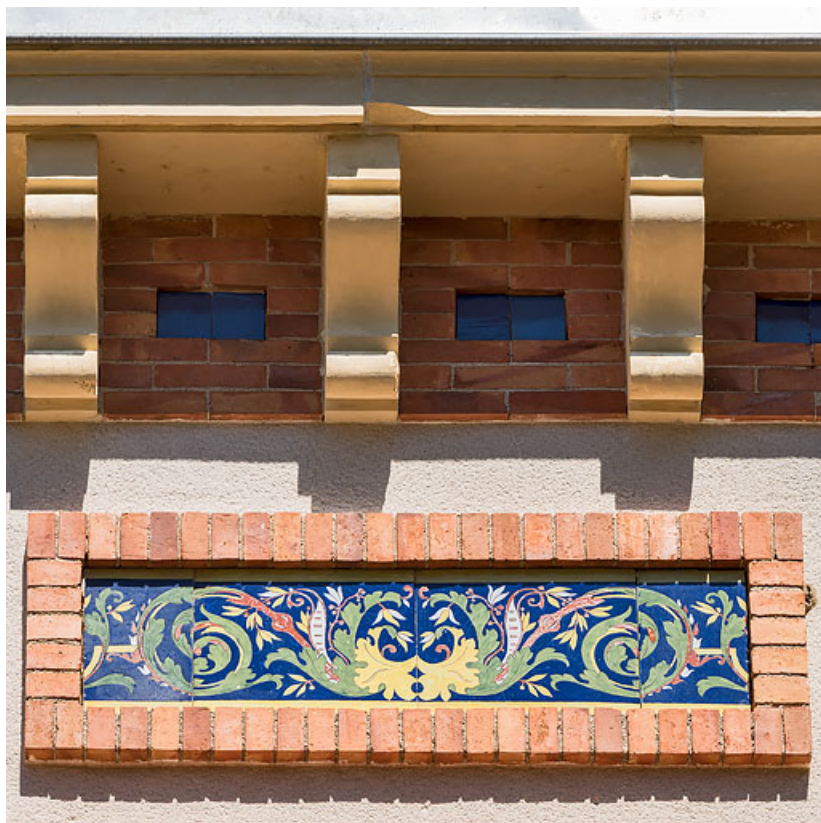
Avant-corps central de la façade principale, détail.
