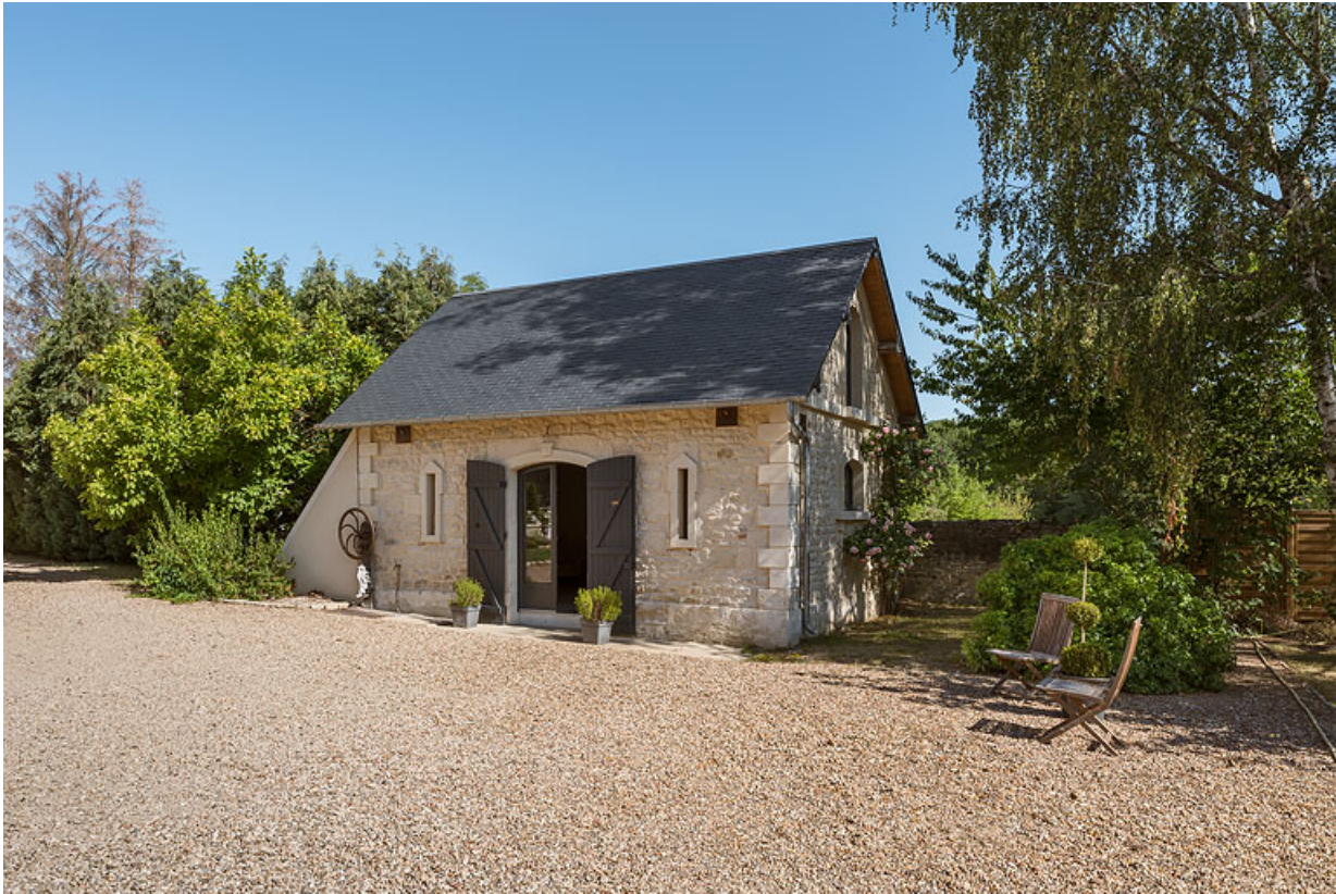
Dépendance (remise-écurie) côté nord. 58, Pougues-les-Eaux, 5 avenue de Paris
