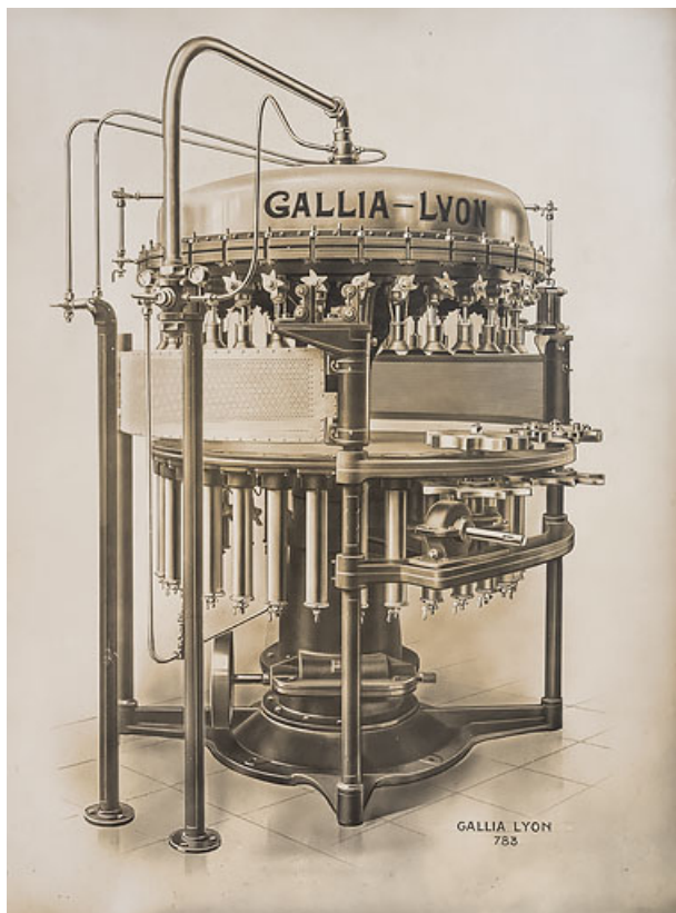
Modèle de machine d'embouteillage (Gallia-Lyon 783).
