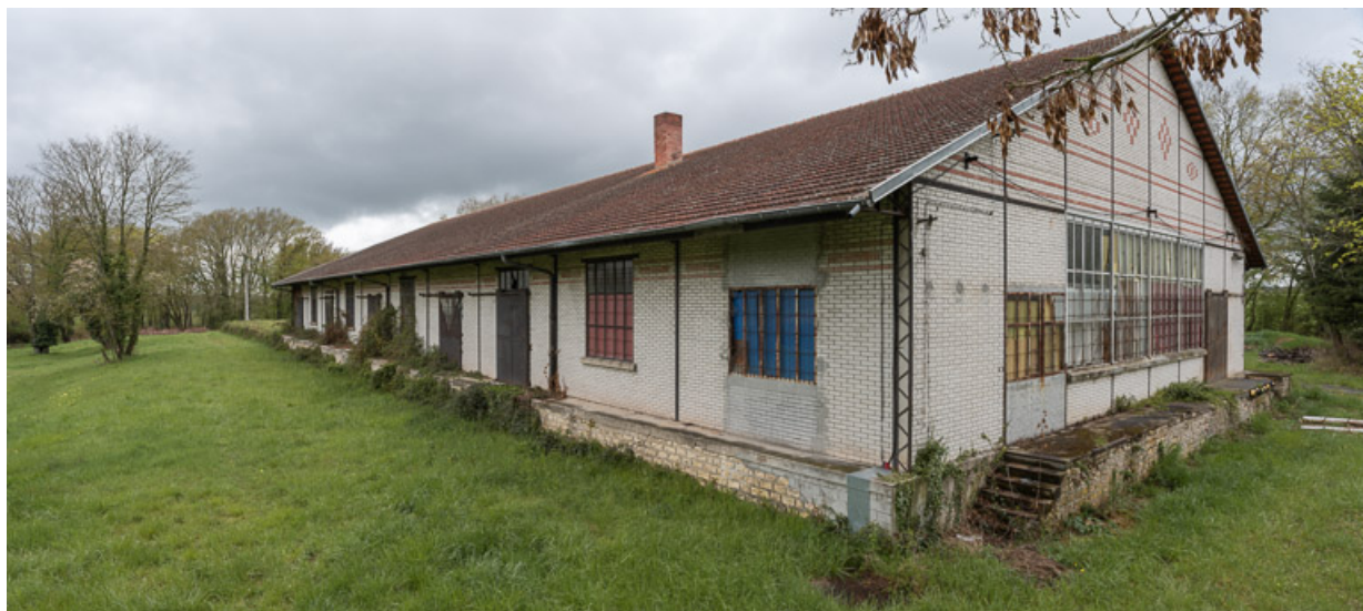
Bâtiment de l'embouteillage construit en 1928, mur pignon est et ancien quai de chargement sud.
