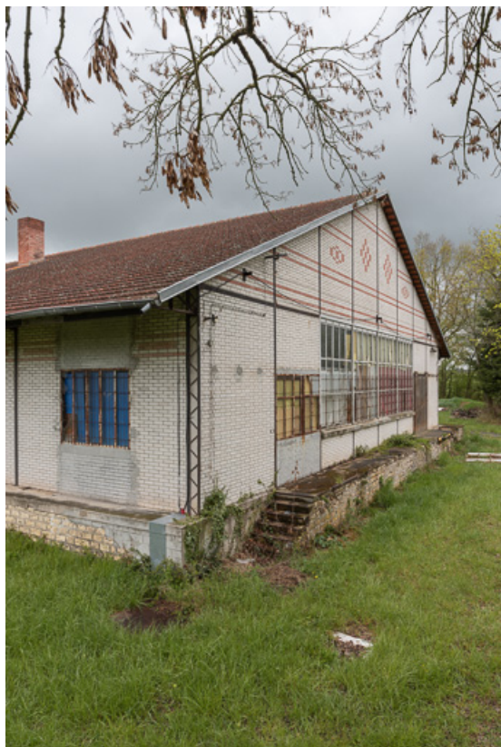
Bâtiment de l'embouteillage construit en 1928, mur pignon est et ancien quai de chargement sud. 58, Pougues-les-Eaux rue des Sources, lieudit : Le Ponteau
