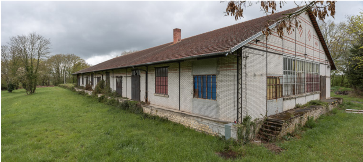
Bâtiment de l'embouteillage construit en 1928, mur pignon est et ancien quai de chargement sud. 58, Pougues-les-Eaux rue des Sources, lieudit : Le Ponteau
