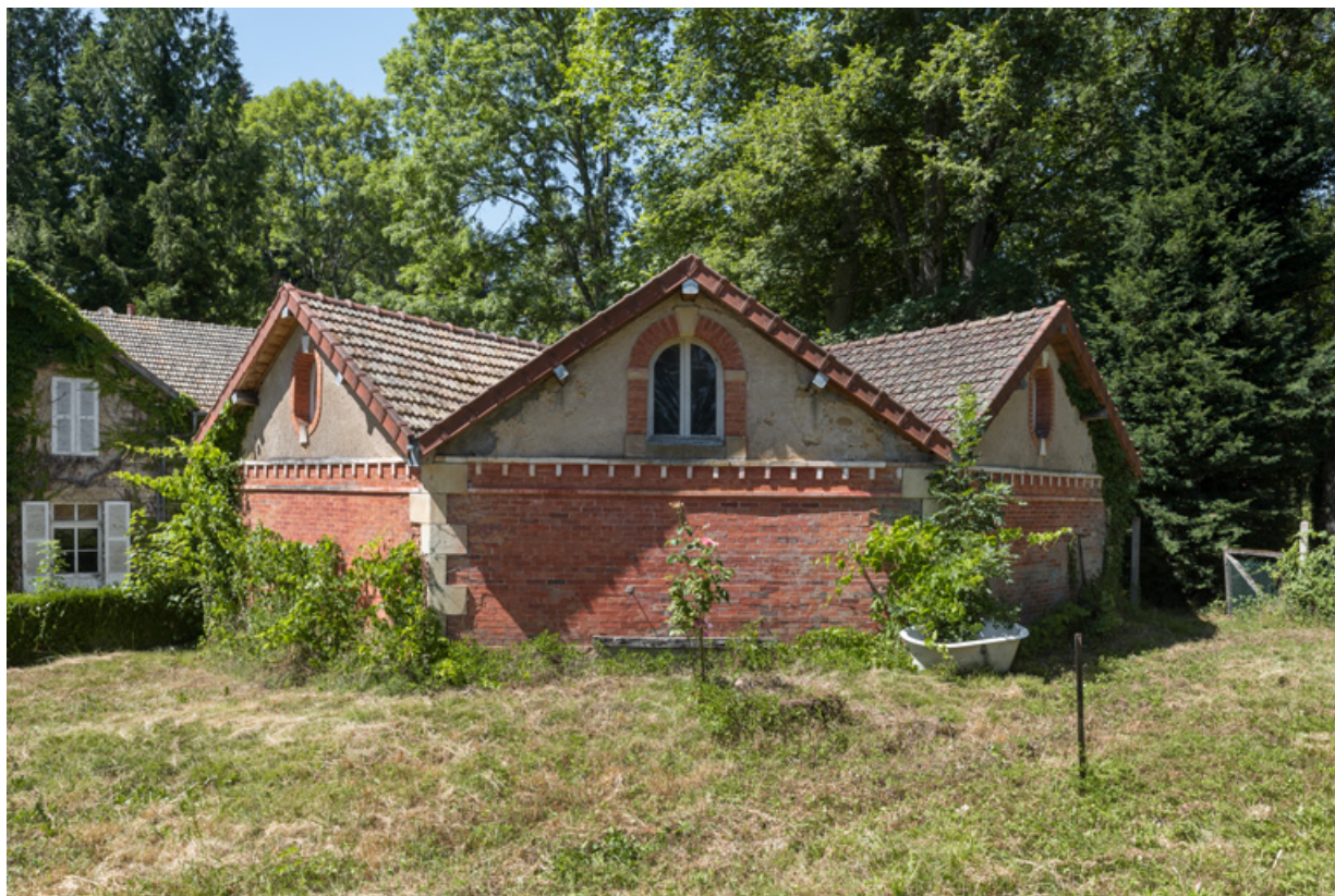
Vue depuis l'est-sud-est.
