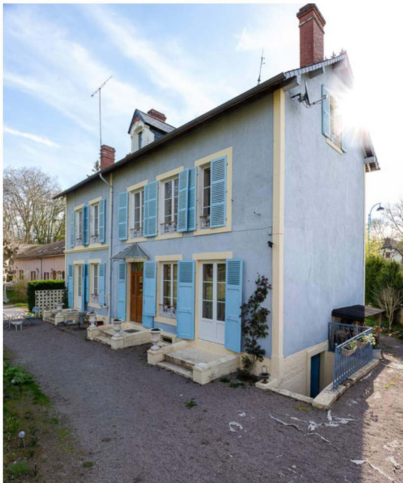
Façade nord-ouest et pignon sud-ouest.
