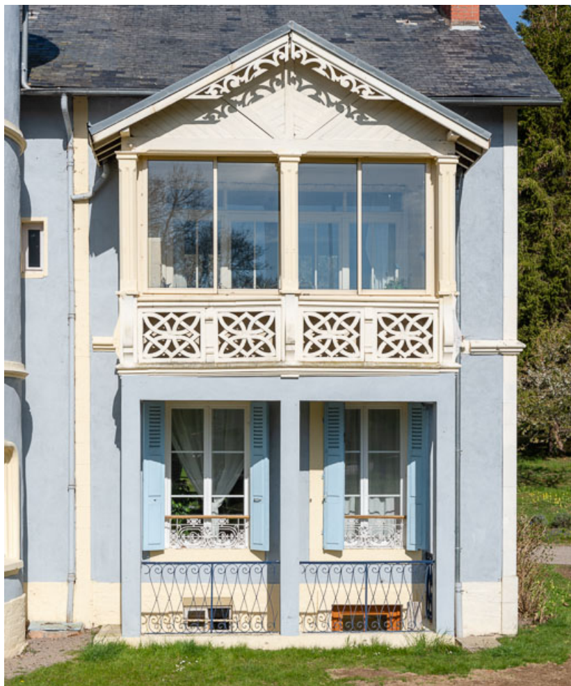
Façade sud-est, oriel.
