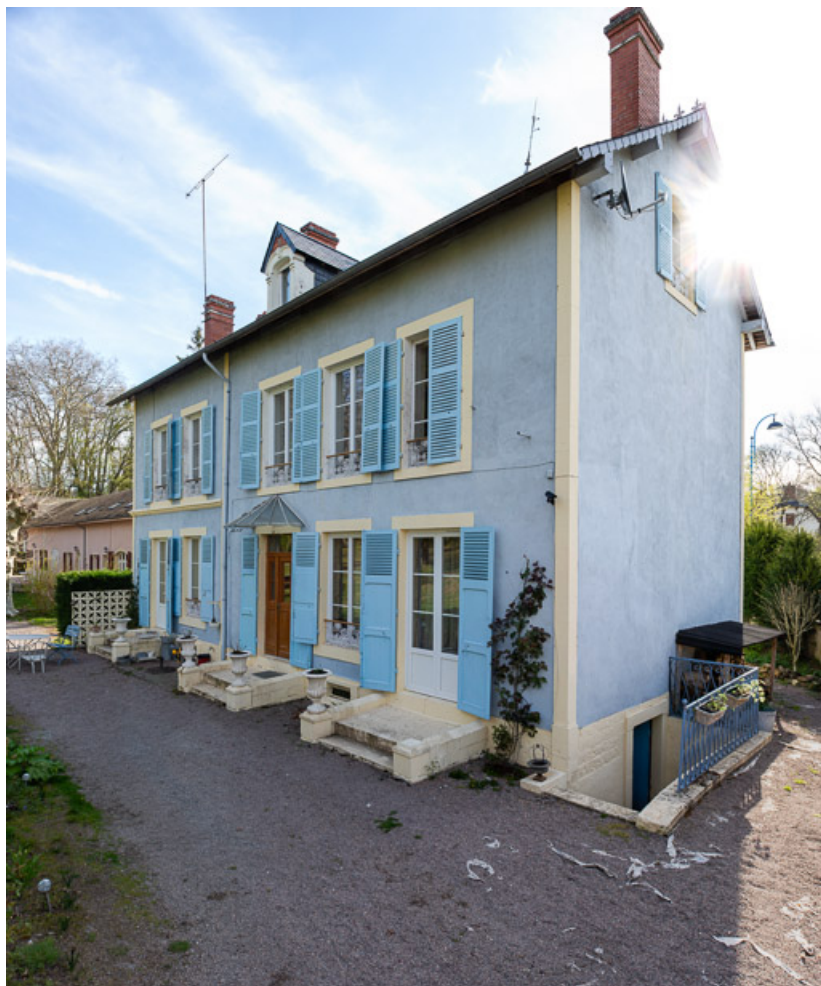
Façade nord-ouest et pignon sud-ouest.
