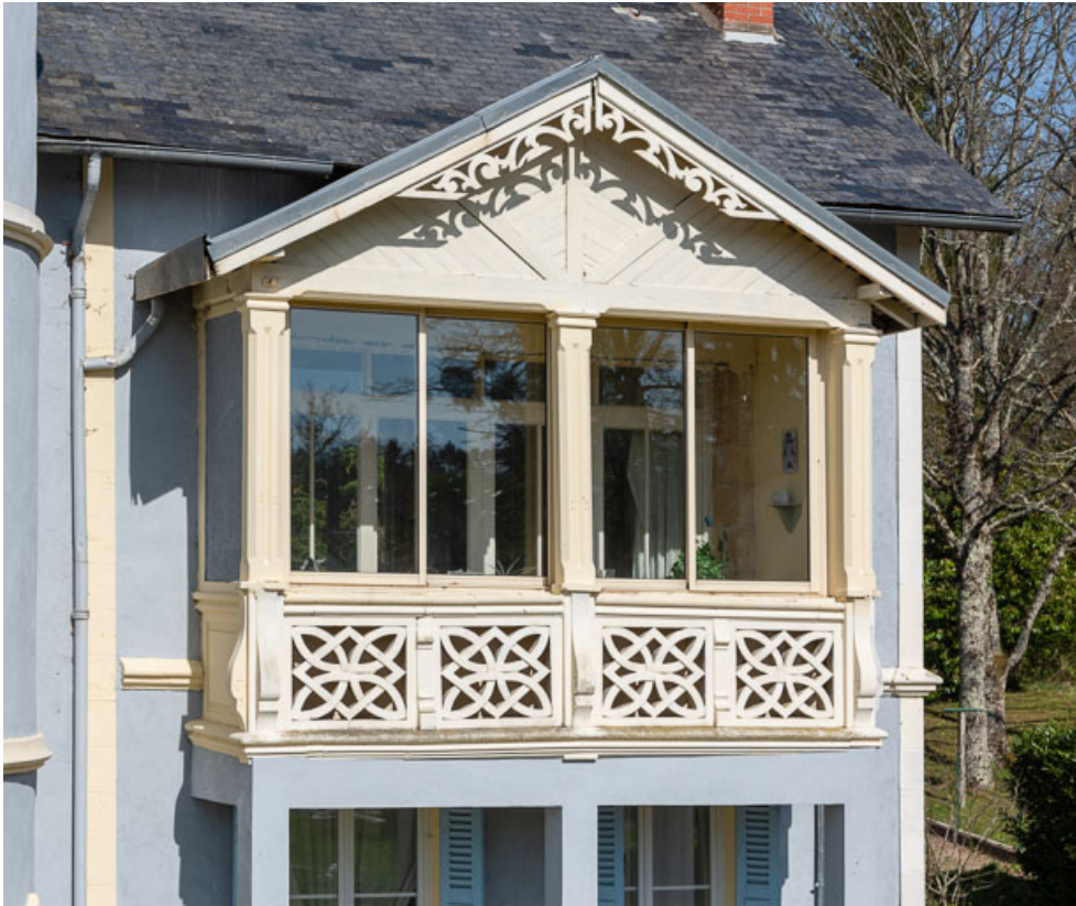
Façade sud-est, oriel.
