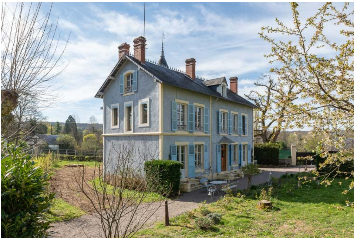
Façade nord-ouest et mur pignon nord-est.
