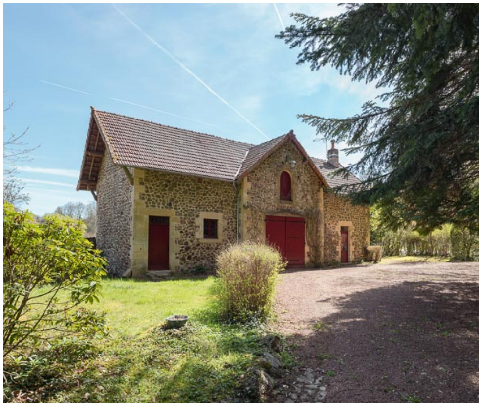
Façade principale donnant sur la villa.
