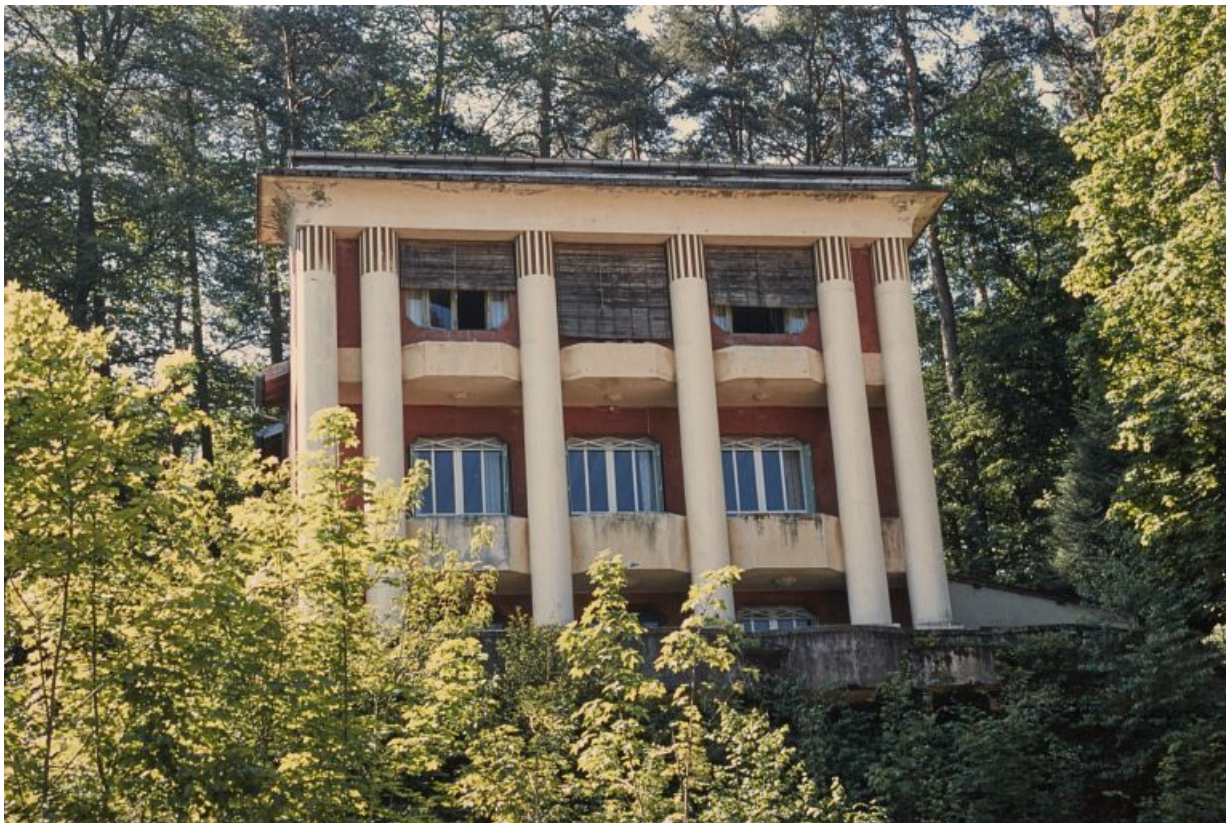
Façade nord, vue de face.
