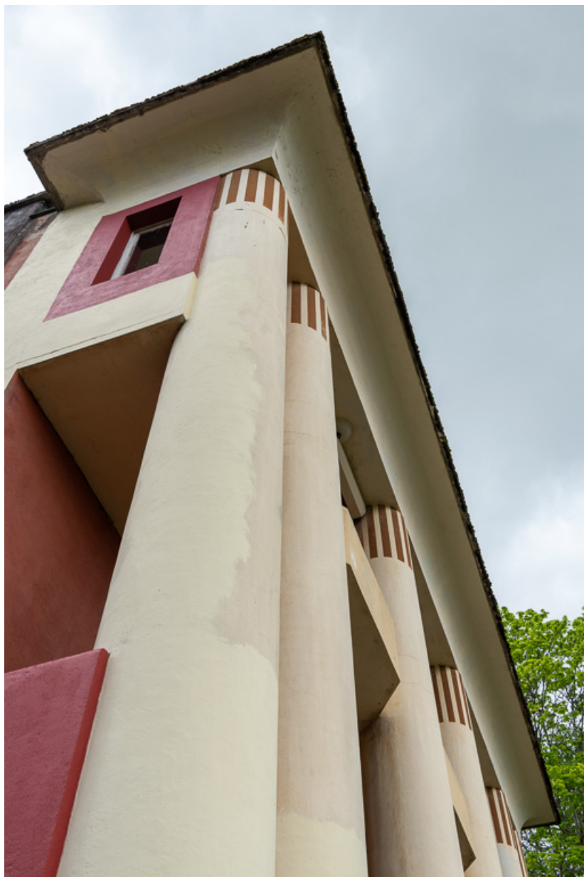
Corniche surmontant le troisième niveau de la façade nord.
