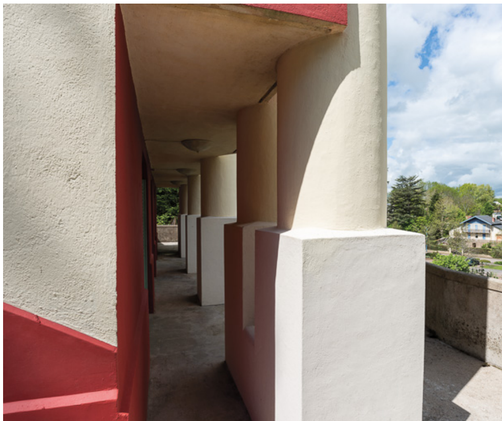
Terrasse de la façade nord, socle des colonnes.
