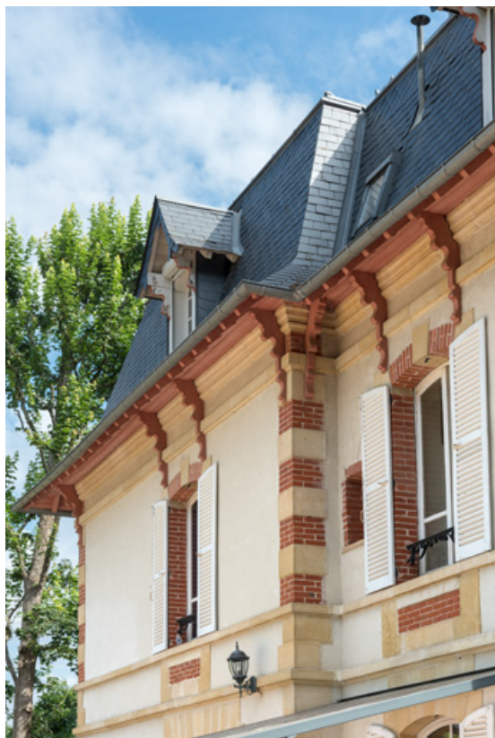
Détail de l'avant-corps de la façade postérieure, baies de l'étage carré et toiture à égout retroussé. 58, Saint-Honoré-les-Bains, 29 avenue Eugène Collin
