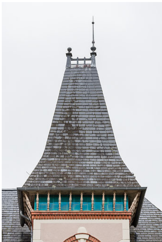
Tour demi-hors-œuvre, toiture et crête faitière.
