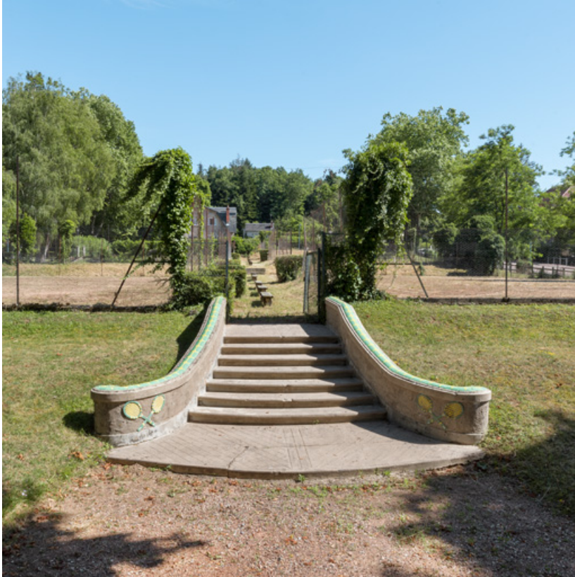
Escalier conduisant aux courts de tennis, vue de face.
