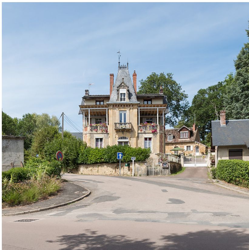
Façade principale, vue depuis l'avenue Jean Mermoz.
