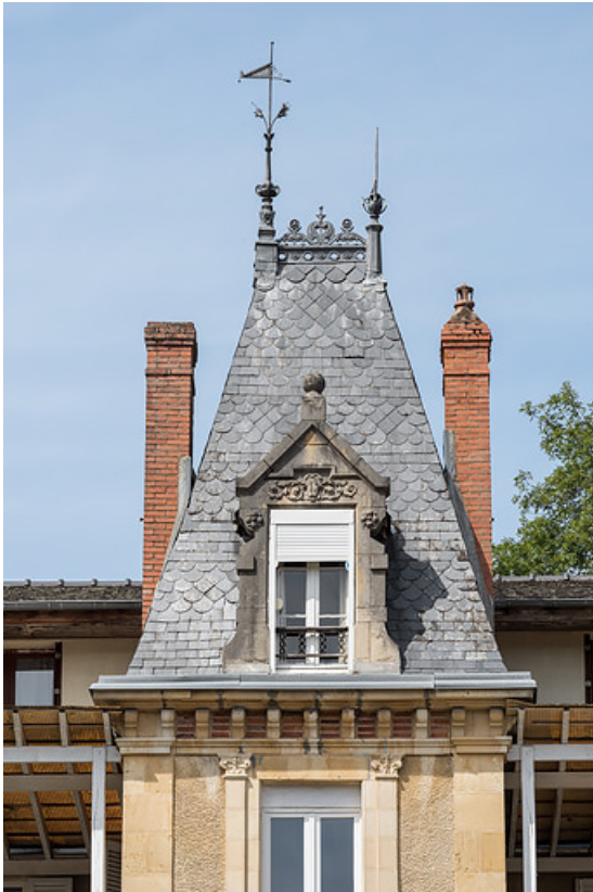
Toit à quatre pans en ardoise de la tour avec crête et épi de faîtage.
