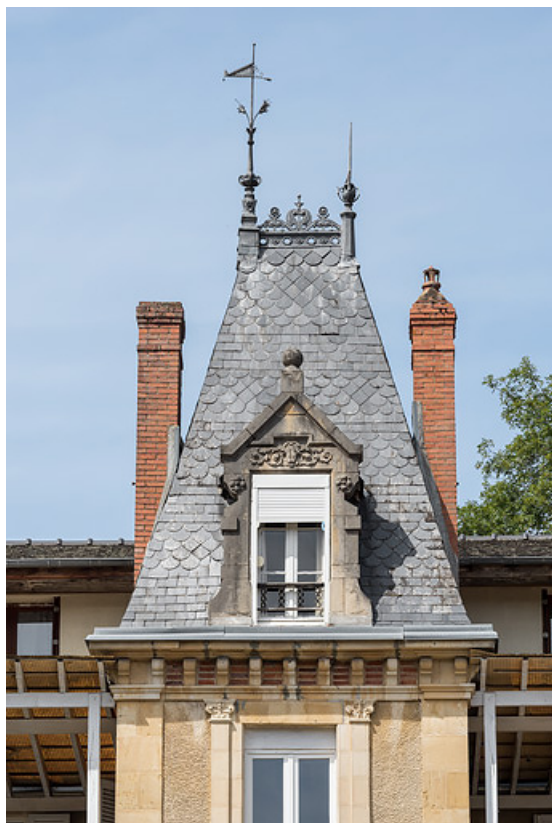
Toit à quatre pans en ardoise de la tour avec crête et épi de faitage.
