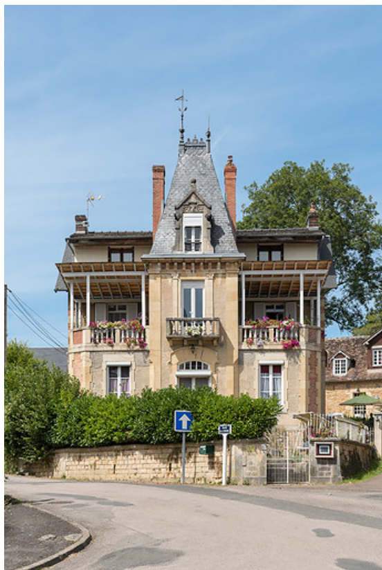
Façade principale, vue depuis la rue de la Chaume.
