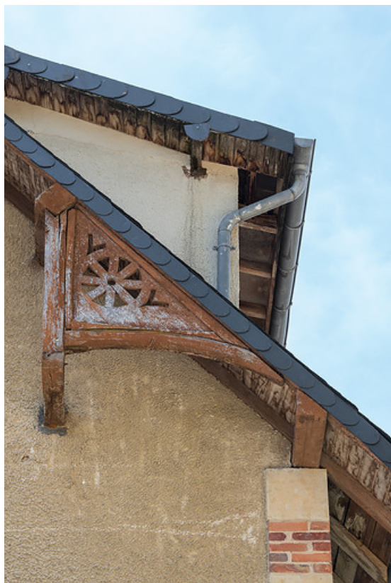
Pignon nord-est, éléments de charpente apparente (sous-arbalétriers, cercles). 58, Saint-Honoré-les-Bains, 1 rue de la Chaume
