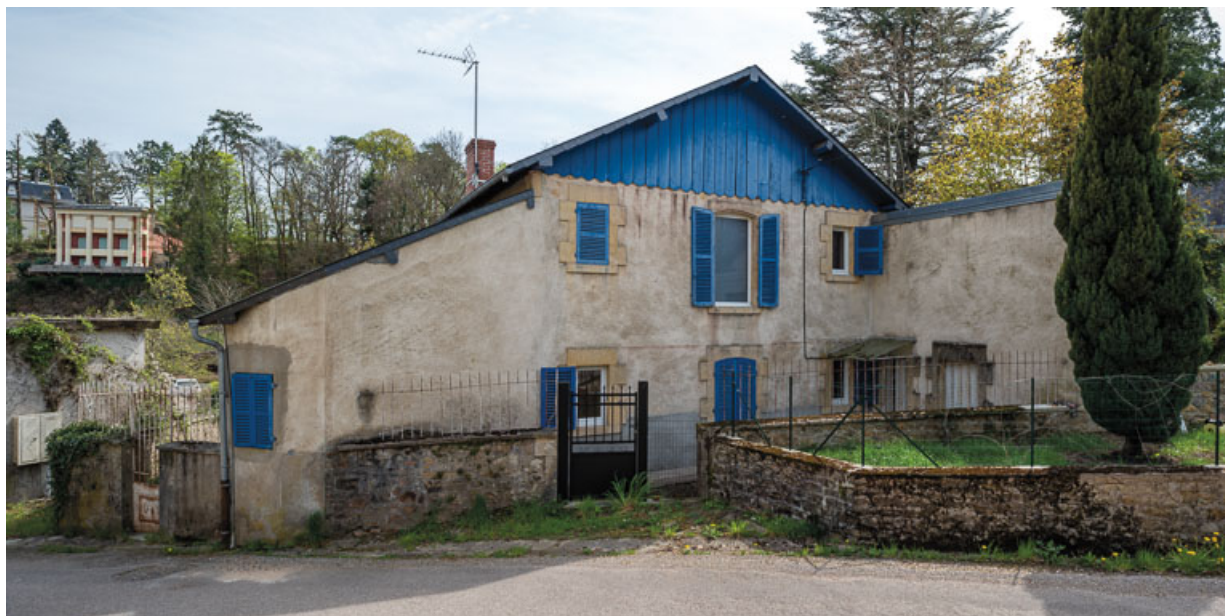
Élévation sur la rue de la Chaume, vue depuis le nord avec la Villa Marinette à l'arrière-plan. 58, Saint-Honoré-les-Bains, 6 avenue Jean Mermoz
