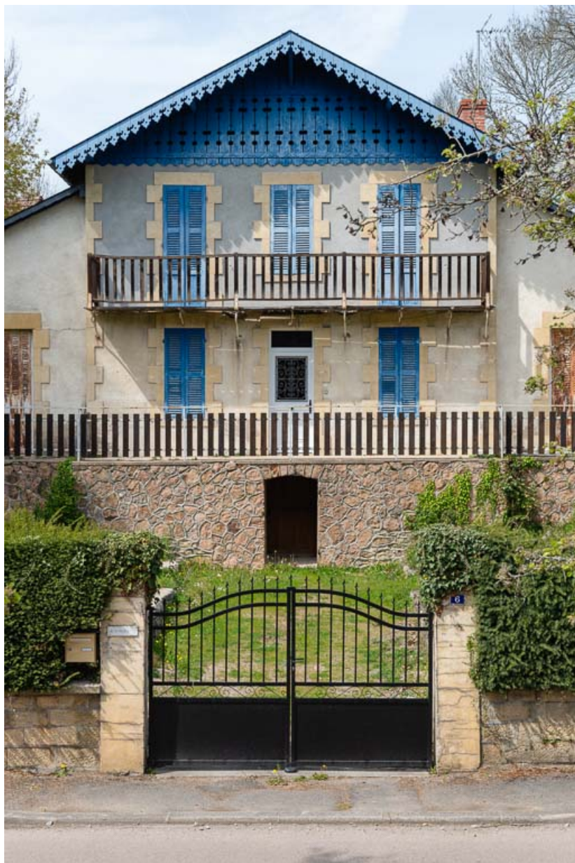
Façade principale, détail de l'avant-corps, vue de face.
