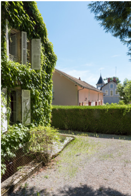
Vue d'ensemble de la Villa Les Lierres (premier plan), du Pavillon Rose et du Pavillon Blanc. 58, Saint-Honoré-les-Bains, 26 avenue Jean Mermoz
