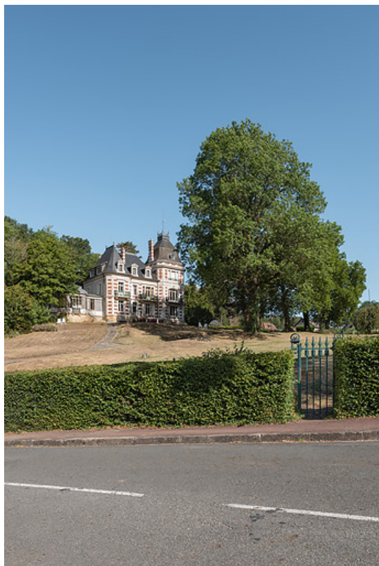
Vue d'ensemble du site depuis la rue Joseph Duriaux.
