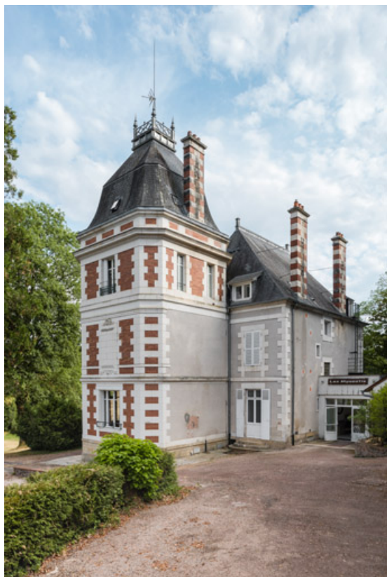
Pavillon nord, vue depuis le nord-est.
