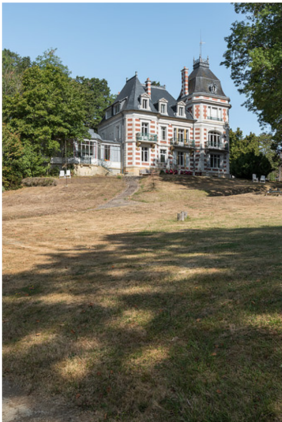
Façade, vue de trois-quarts depuis le sud.
