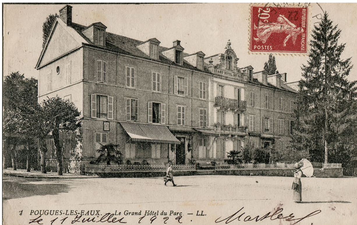
Vue extérieure de l'hôtel après la mise au goût du jour de la façade au début du 20e siècle.
