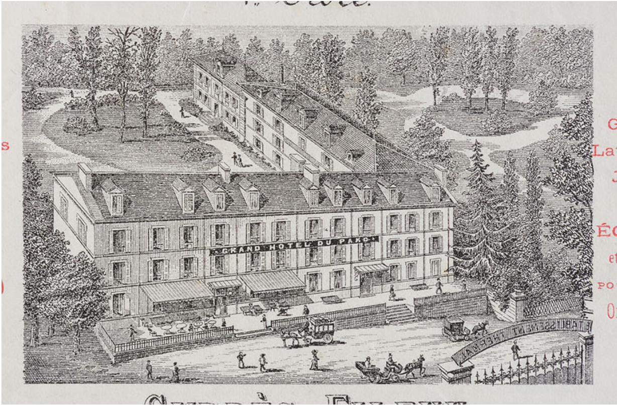
Vue aérienne de l'hôtel après l'agrandissement de 1888.
