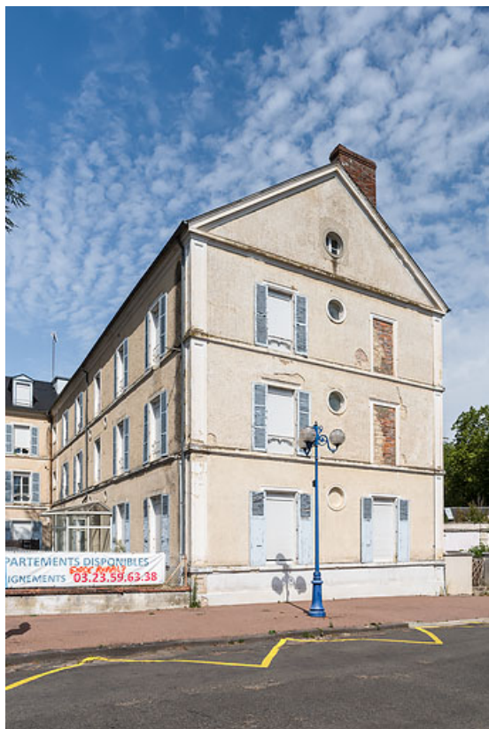
Façade est du corps principal, vue en 2020.
