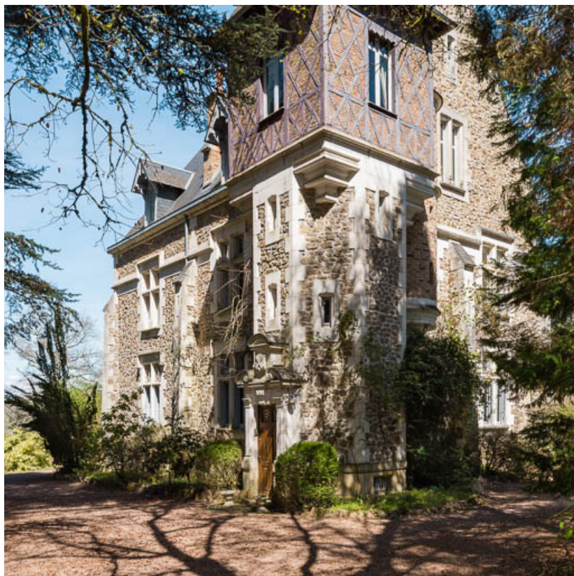
Tour d'angle de plan octogonal (aux deux premiers niveaux) et carré (au troisième niveau) contenant l'escalier en vis. 58, Saint-Honoré-les-Bains, 24 avenue de Rémilly
