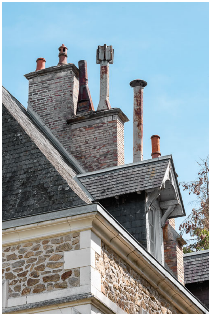
Couverture en ardoise, lucarnes et cheminées.
