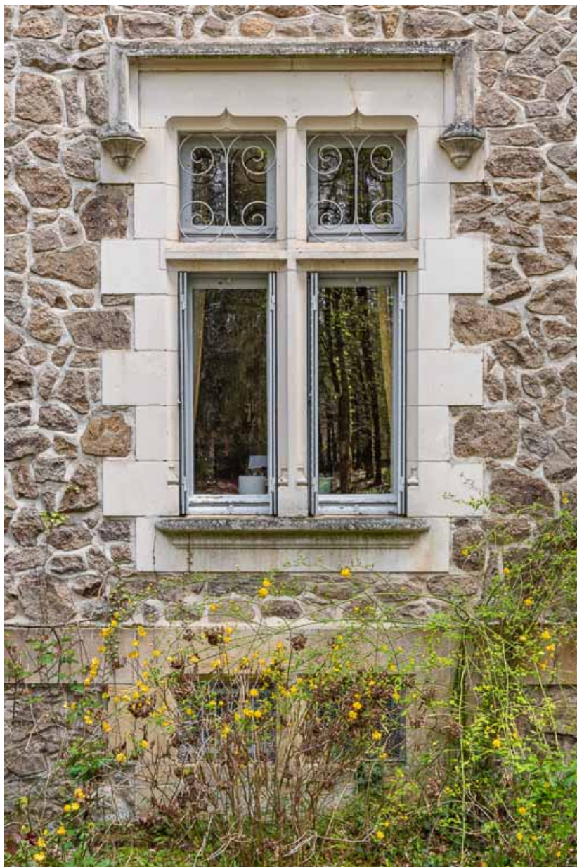
Croisée couverte d'un linteau décoré d'accolades (baie du rez-de-chaussée de la façade sud-ouest). 58, Saint-Honoré-les-Bains, 24 avenue de Rémyilly
