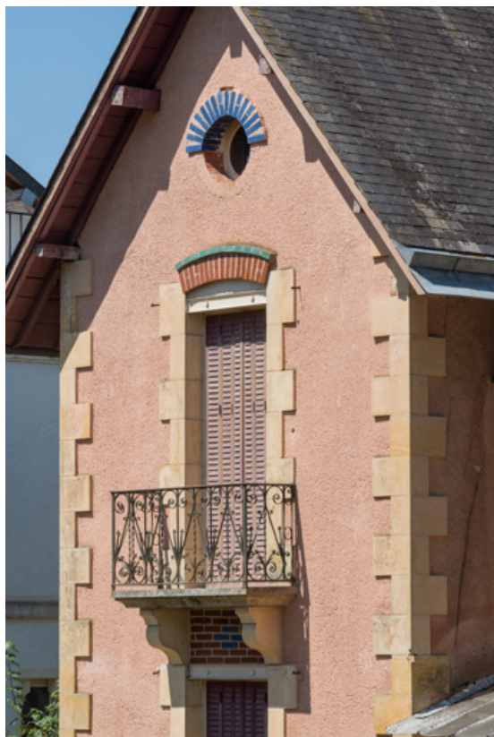
Mur-pignon, détail des ouvertures, vue de trois-quarts.
