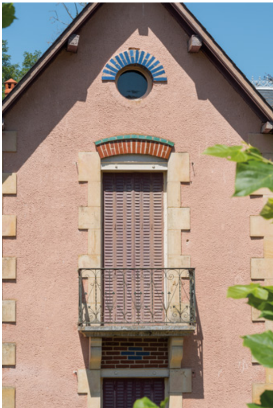
Mur-pignon, détail des ouvertures, vue de face.
