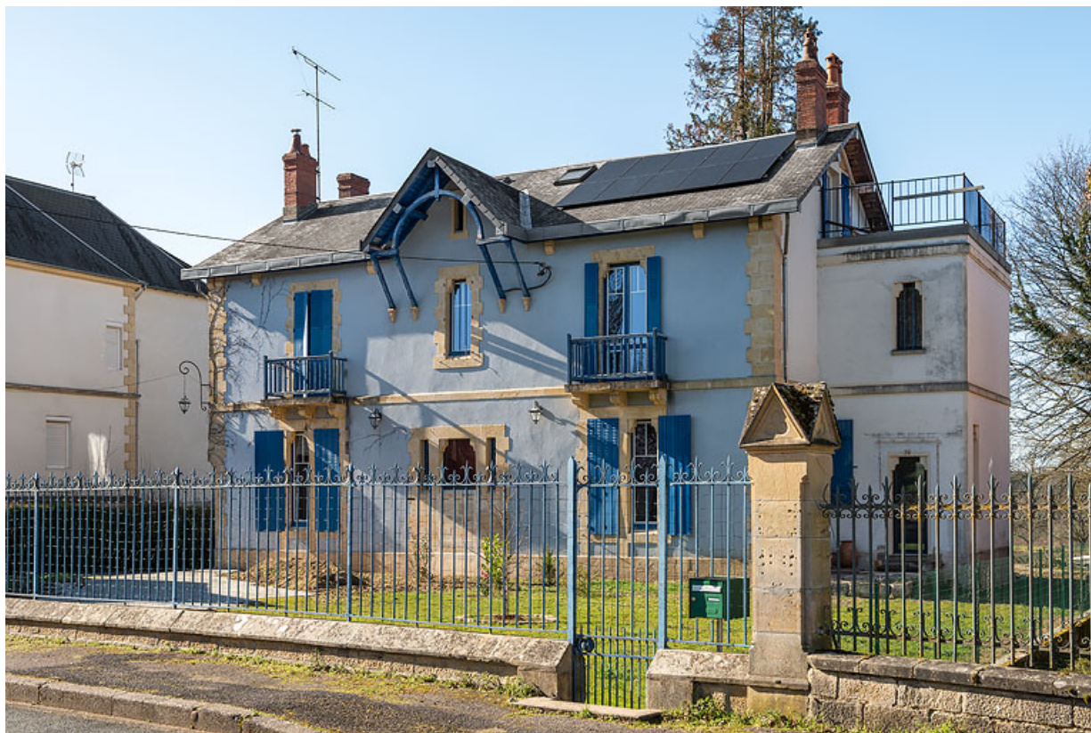
Façade sur l'avenue, vue de trois-quarts depuis l'est.
