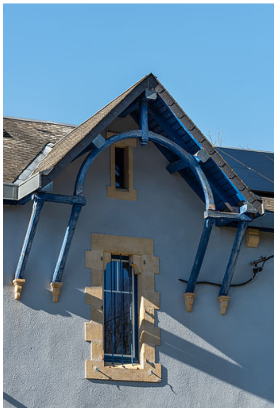
Lucarne-pignon à toiture débordante.
