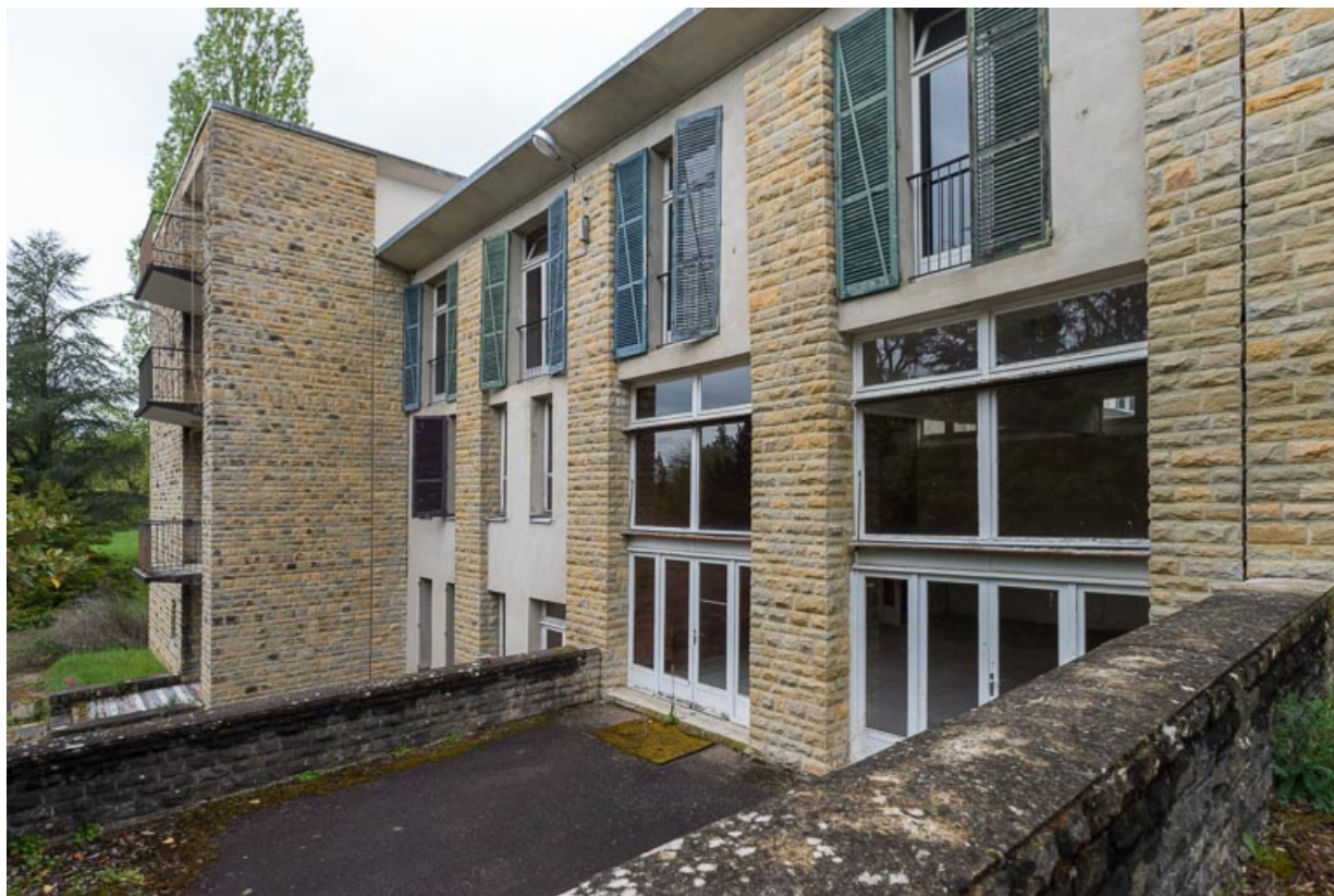
Élévation extérieure de l'aile Régina, côté sud, jonction avec le corps de bâtiment principal. 58, Saint-Honoré-les-Bains, 20 avenue Jean Mermoz
