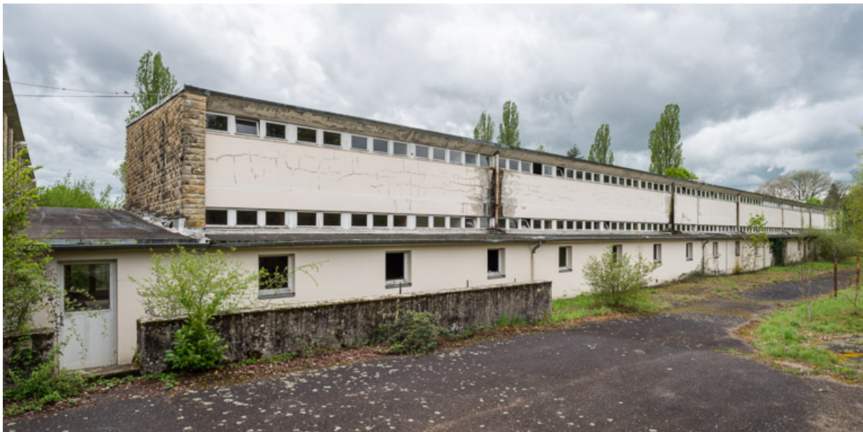
Élévation extérieure de l'aile Bellevue, côté nord. 58, Saint-Honoré-les-Bains, 20 avenue Jean Mermoz
