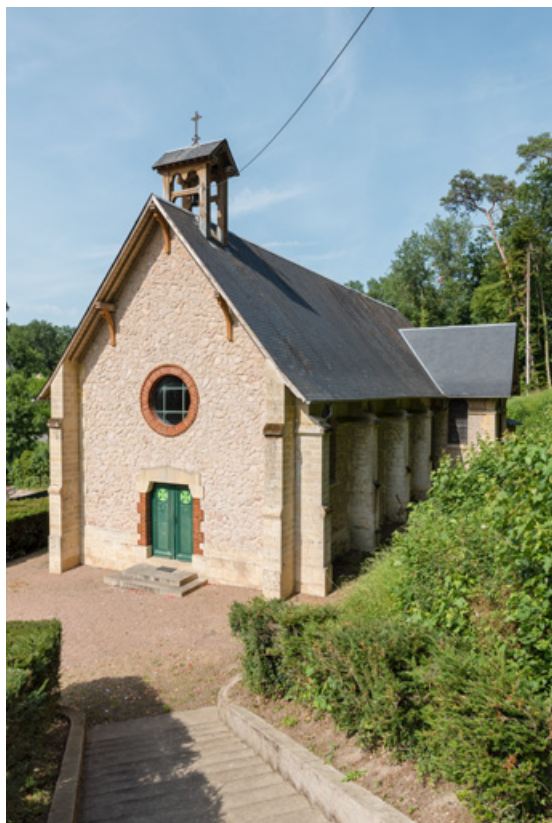
Façade et escalier montant à la colline des Garennes. 58, Saint-Honoré-les-Bains, 7 allée de la Chapelle
