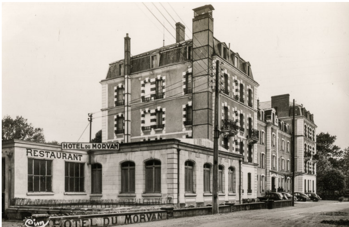
Façade sur l'actuelle avenue Jean Mermoz après l'agrandissement du restaurant. 58, Saint-Honoré-les-Bains, 9 avenue Jean Mermoz
