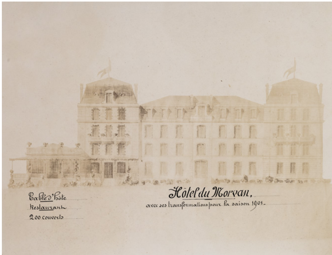
Façade sur le parc après la construction des pavillons latéraux.
