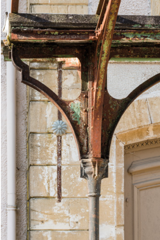
Marquise de la façade sur l'avenue, détail.
