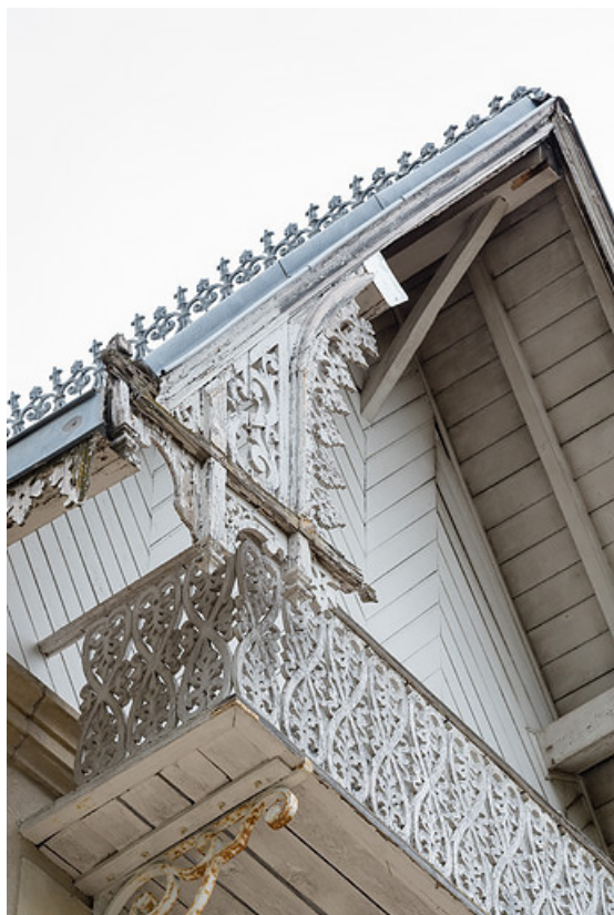
Lambrequins et garde-corps du balcon en bois ajouré.
