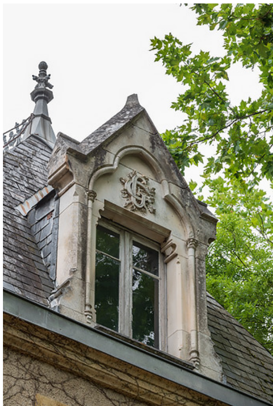
Lucarne à l'extrémité du corps oriental portant le chiffre de Gilbert Charleuf ("G.C.") associé à des branches de houx. 58, Saint-Honoré-les-Bains, 8 avenue Jean Mermoz
