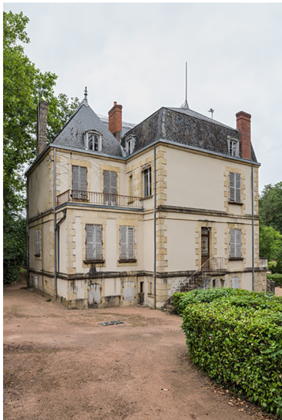
Élévation sud-ouest, vue depuis l'ouest.
