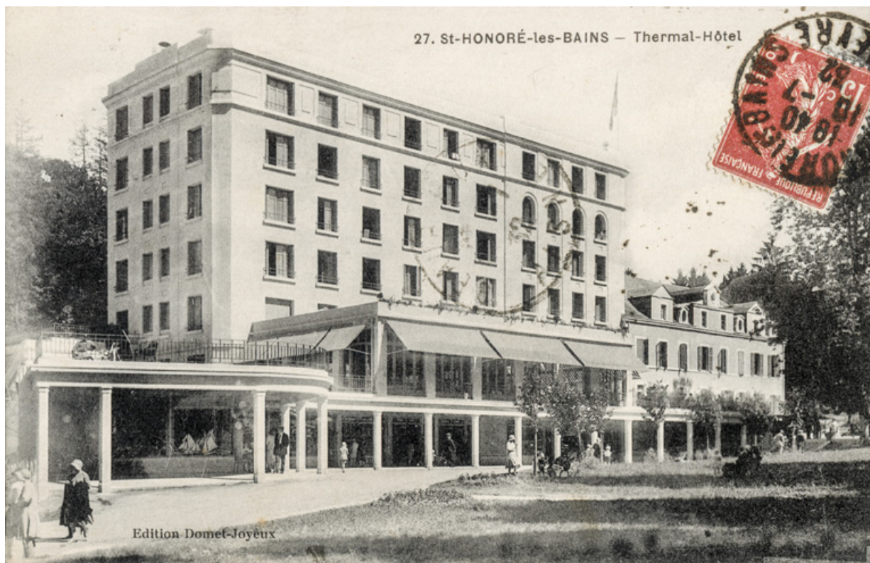
Façade sur le parc avant la transformation de la toiture.
