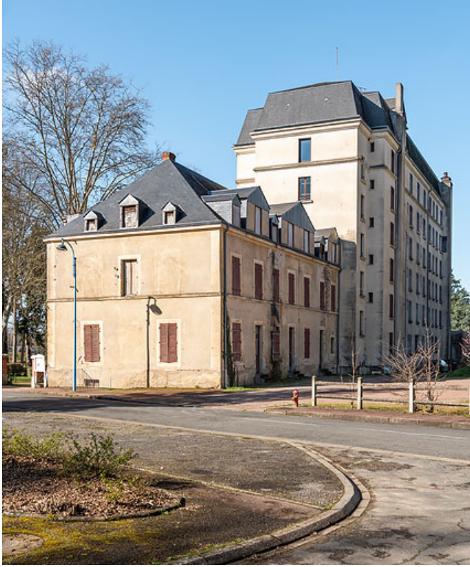
Façade postérieure, vue depuis la rue, avec l'Hôtel des Bains (à gauche). 58, Saint-Honoré-les-Bains, 16 rue Joseph Duriaux
