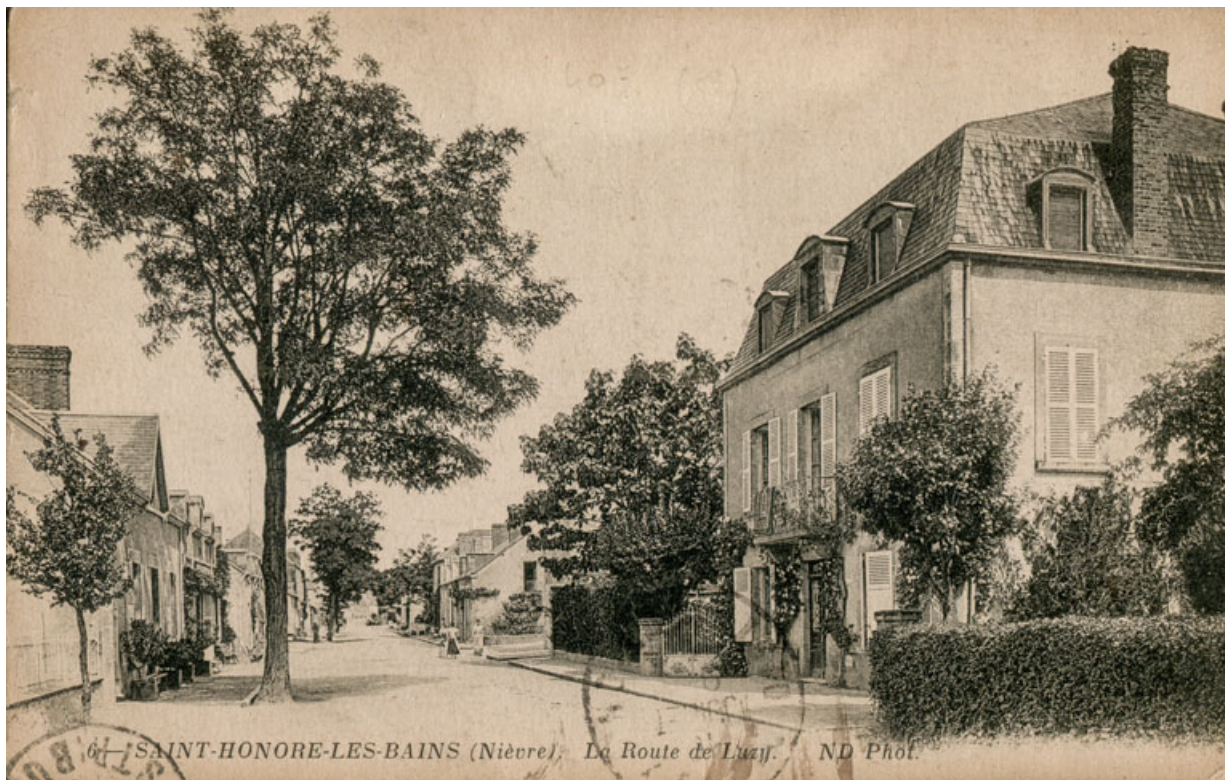
Villa des Roses (aujourd'hui détruite) sur la route de Luzy (actuelle avenue du Général d'Espeuilles). 58, Saint-Honoré-les-Bains
