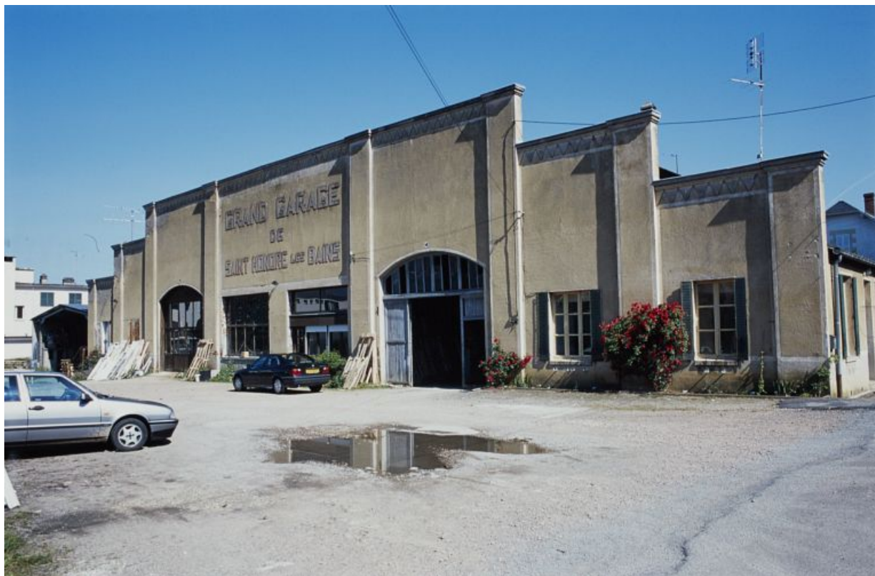
Vue d'ensemble depuis la rue Félicie Musset. 58, Saint-Honoré-les-Bains, 3 rue Félicie Musset
