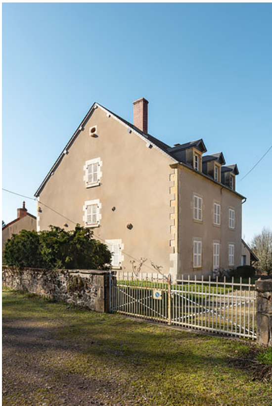
Maison (16 avenue de Rémilly) antérieure au développement du quartier thermal. 58, Saint-Honoré-les-Bains
