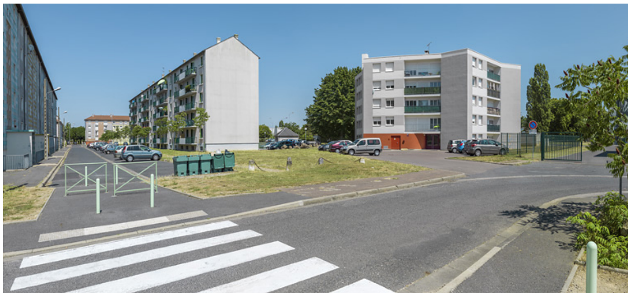
Bâtiment E, SIDEN et X depuis la place Pierre et Marie Curie. 58, Cosne-Cours-sur-Loire avenue de Verdun
