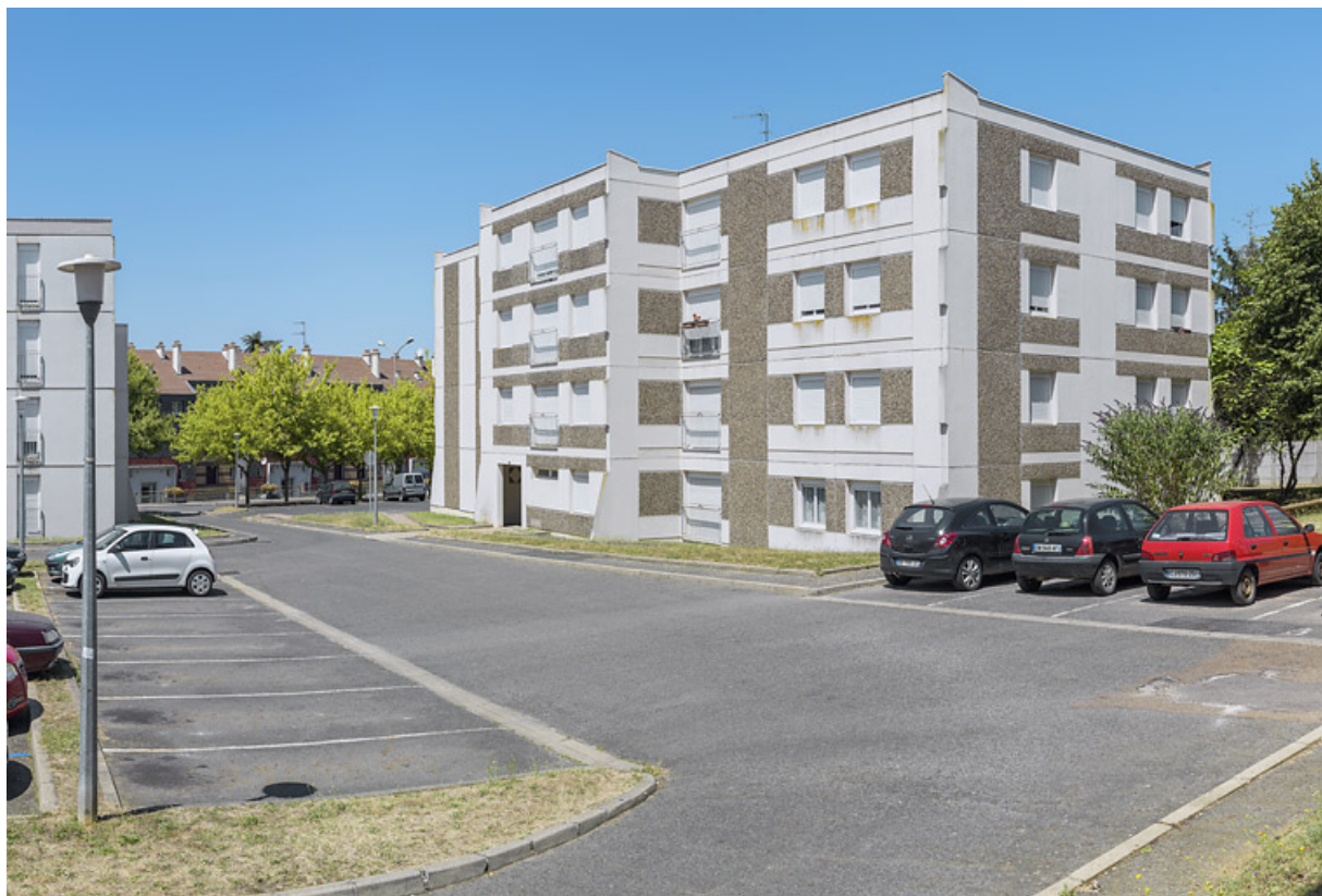
Bâtiment 26, façade antérieure sud et façade latérale est. 58, Cosne-Cours-sur-Loire rue Gay Lussac
