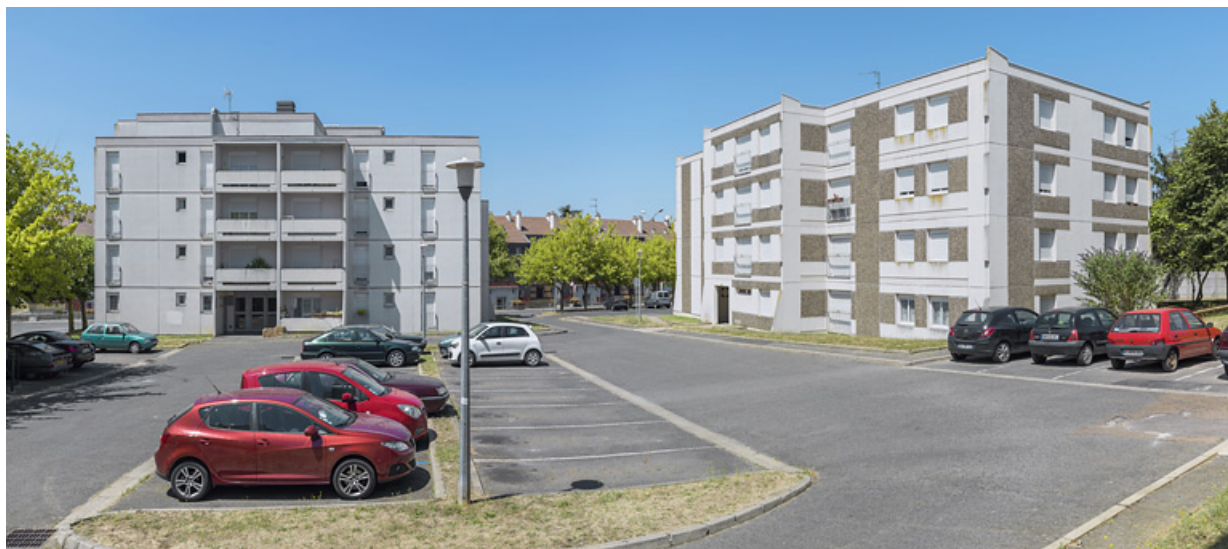
Façade antérieure est du bâtiment 25 et façade antérieure sud du bâtiment 26. 58, Cosne-Cours-sur-Loire rue Gay Lussac
