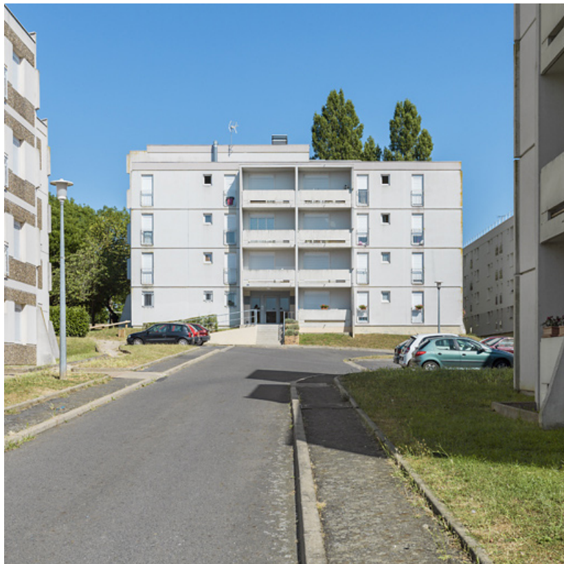
Bâtiment 27, façade antérieure ouest.
