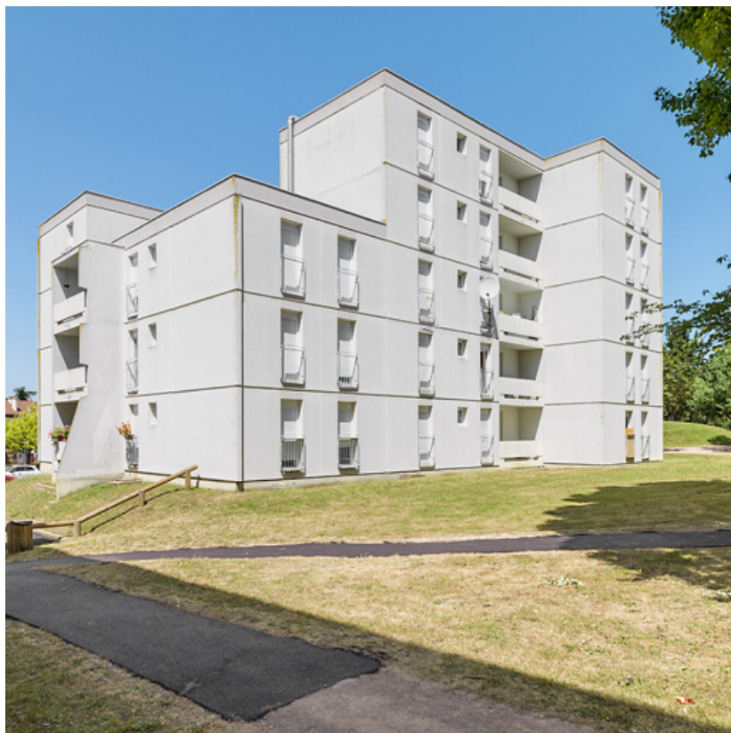
Bâtiment 27, façade latérale sud et façade postérieure est.
