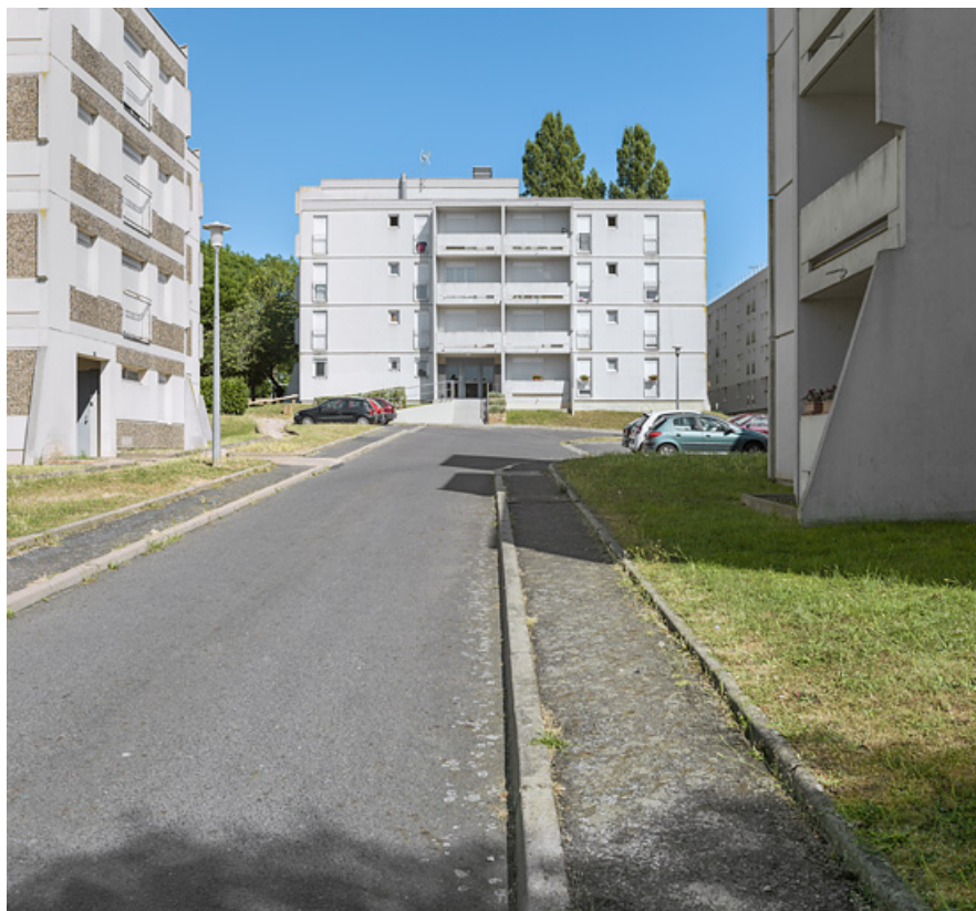
Bâtiment 27, façade antérieure ouest.
