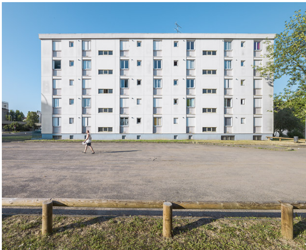
Bâtiment B-1, façade postérieure nord. 58, Cosne-Cours-sur-Loire avenue de la Paix
