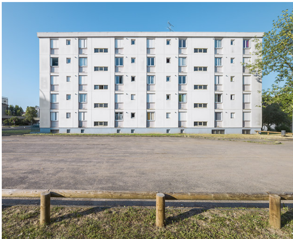
Bâtiment B-1, façade postérieure nord.
