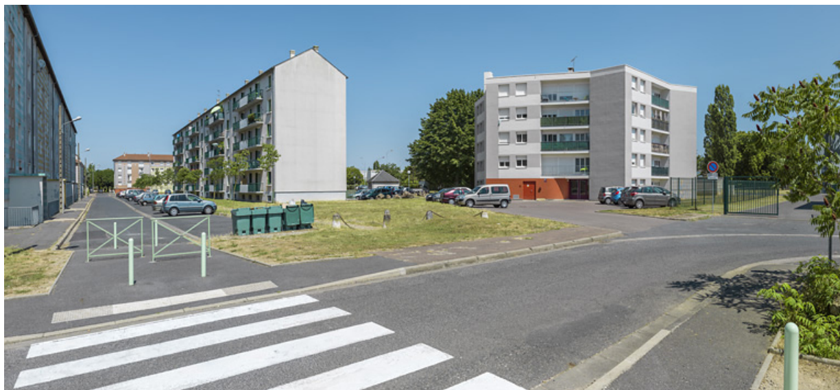
Bâtiment E, SIDEN et X depuis la place Pierre et Marie Curie.
