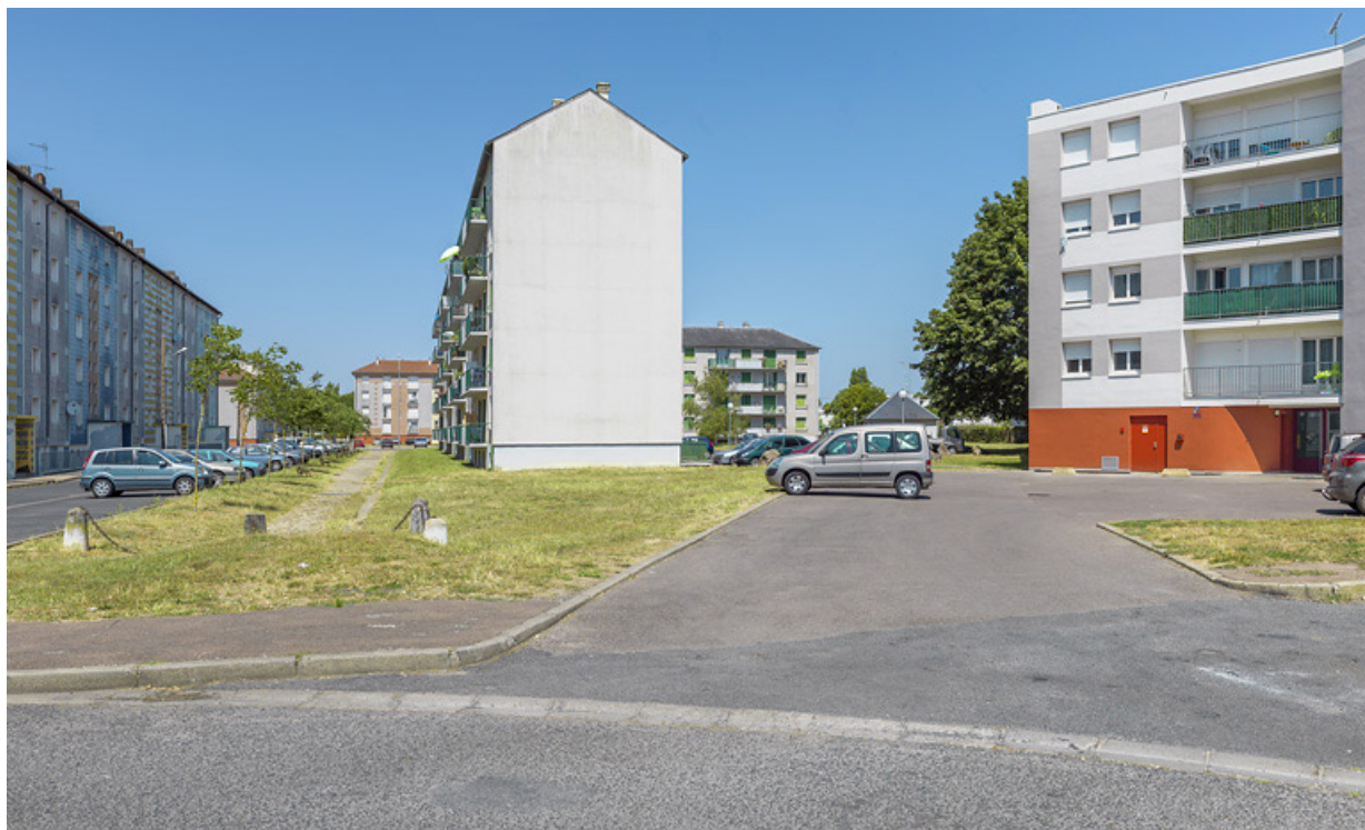
Bâtiment SIDEN, façades postérieure ouest et latérale sud.
