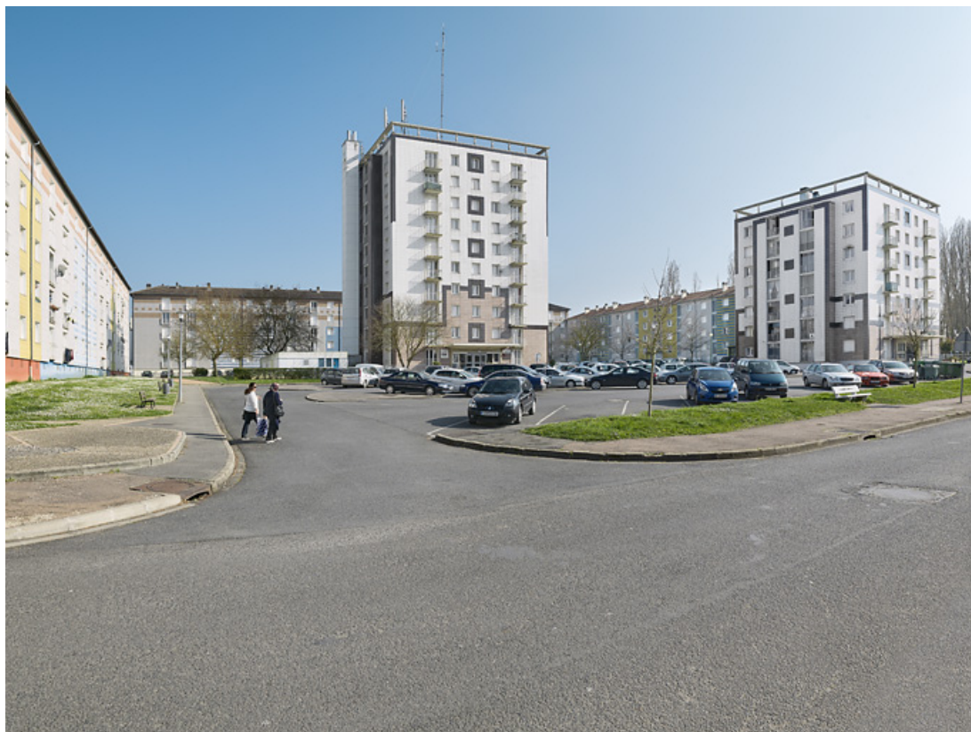
Bâtiments I, E, F et blocs H et G depuis la rue du Berry.
