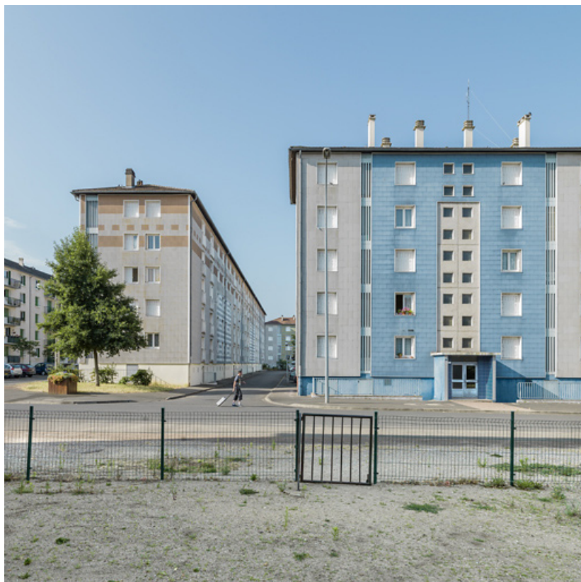
Bâtiment E, façades latérale et postérieure ; bâtiment I façade antérieure. 58, Cosne-Cours-sur-Loire avenue de la Paix
