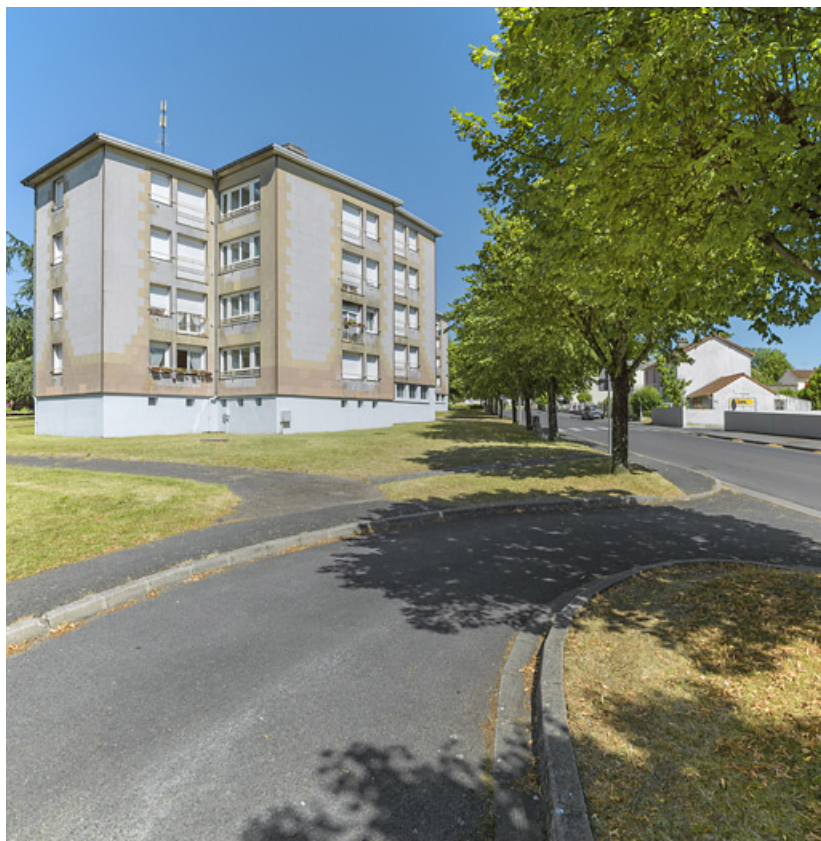
Bâtiment Million-1, façade postérieure sud. 58, Cosne-Cours-sur-Loire rue Fernand Petit
