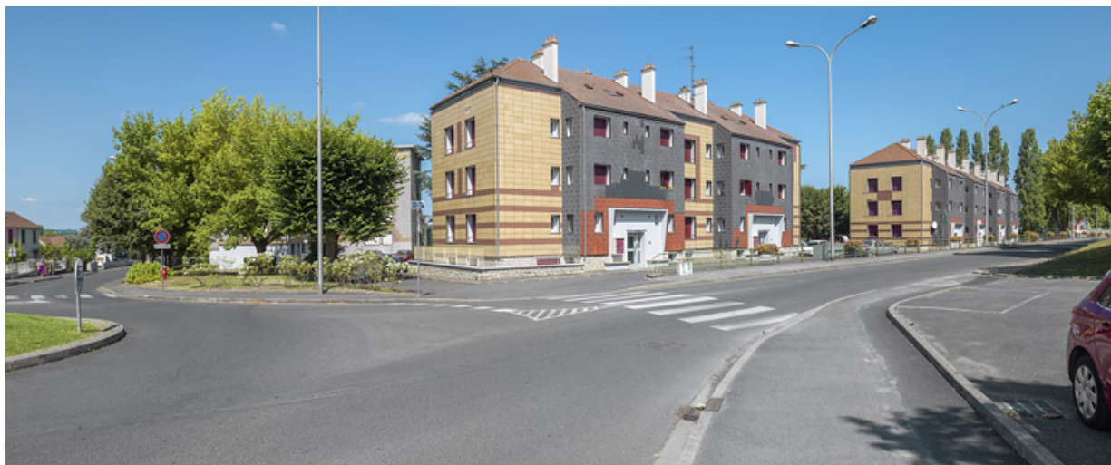
Bâtiments Binot-D et Binot-E, façades antérieures est.
