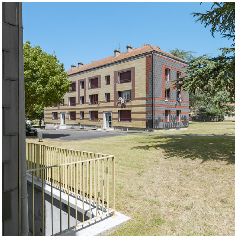
Bâtiment Binot-A, façade antérieure.
