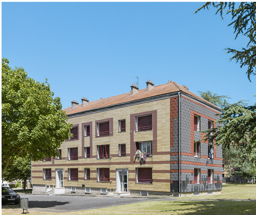
Bâtiment Binot-A, façade antérieure sud. 58, Cosne-Cours-sur-Loire avenue de Verdun
