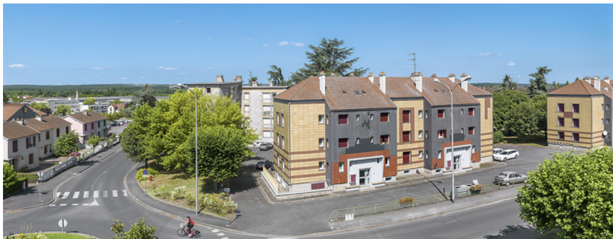
façade antérieure est du bâtiment Binot-D. 58, Cosne-Cours-sur-Loire avenue de Verdun
