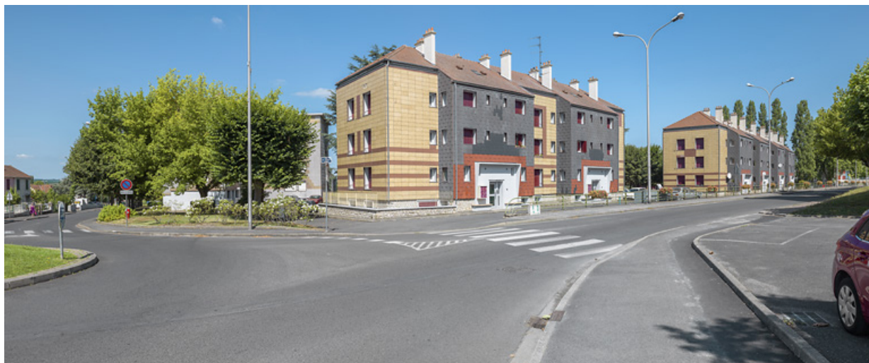
Bâtiments Binot-D et Binot-E, façades antérieures est.
