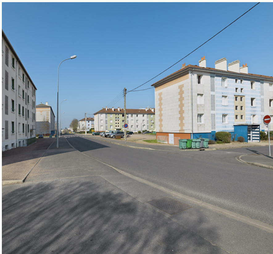
Vue générale depuis le nord de l'avenue de la Paix en direction de l'ouest. 58, Cosne-Cours-sur-Loire avenue de Verdun
