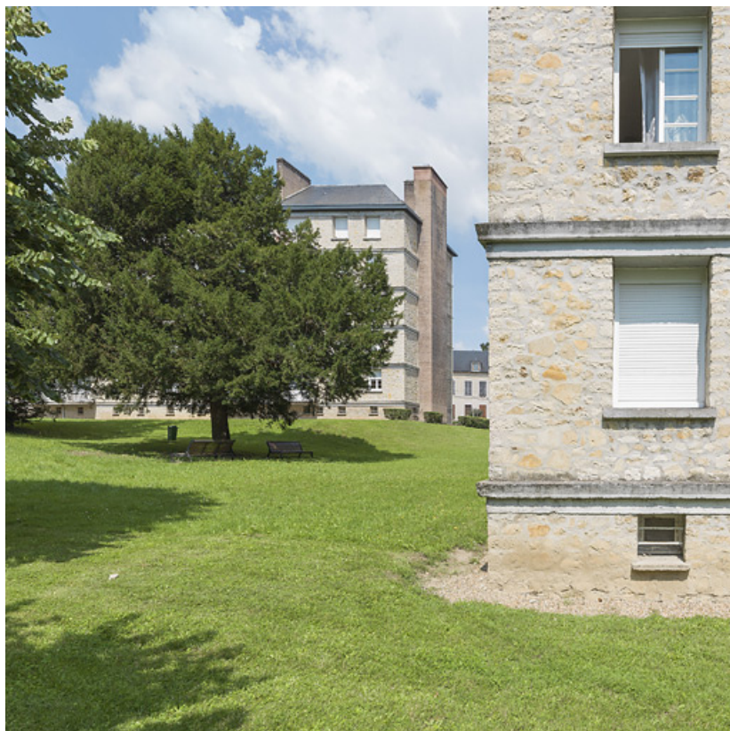
Vue sur la façade postérieure du bâtiment B et le parc central depuis le bâtiment C. 58, Nevers rue de Gonzague
