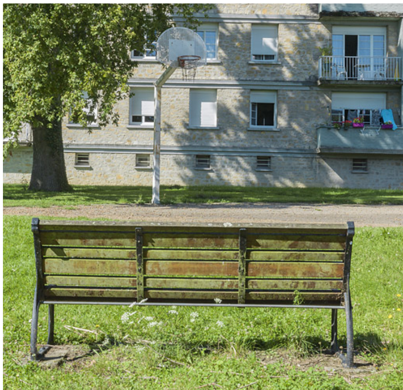
Façade postérieure du bâtiment A et mobilier urbain du parc central. 58, Nevers rue de Gonzague
