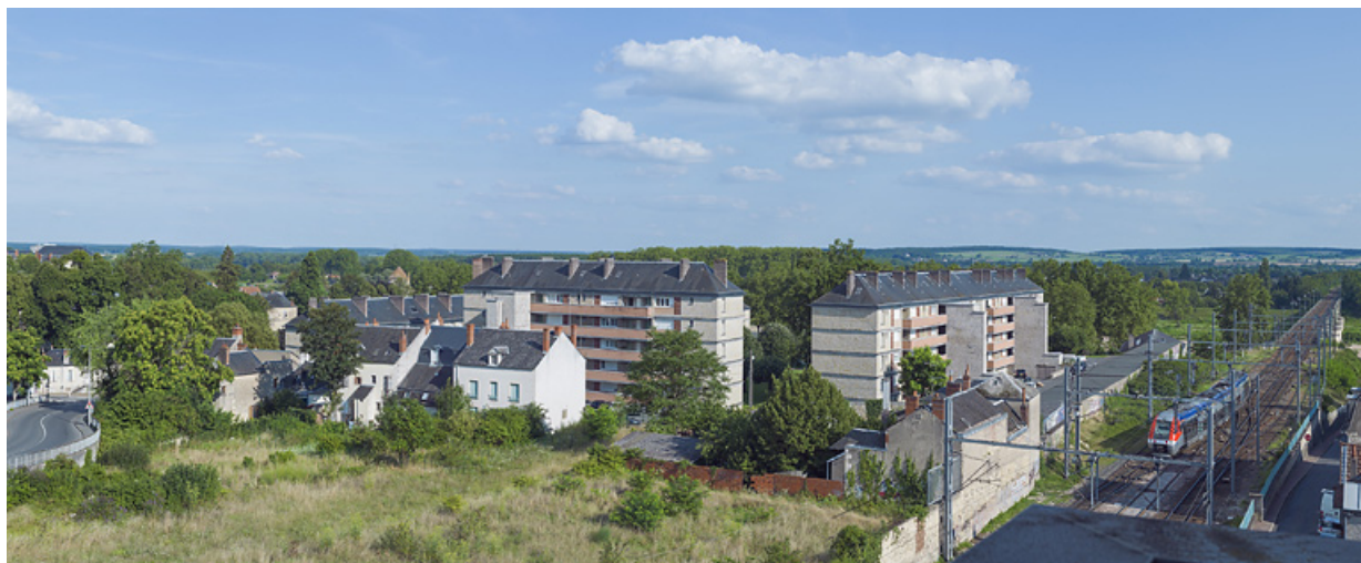
Vue générale depuis le sud-ouest.
