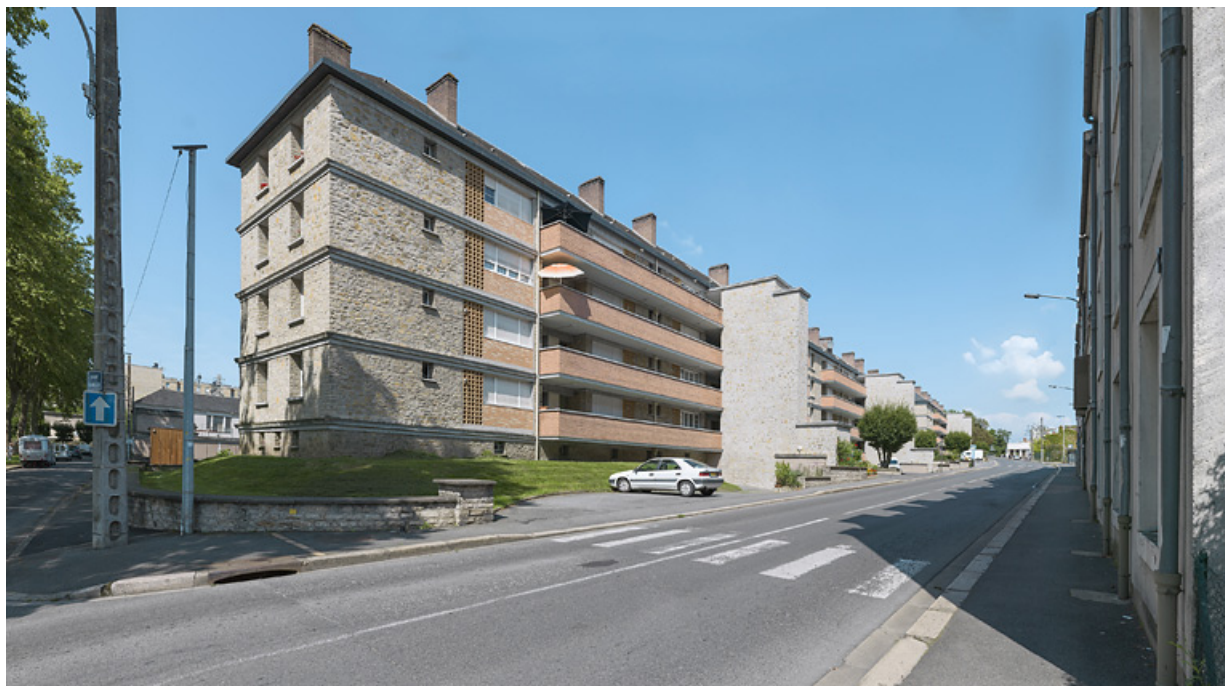
Bâtiment D : façades antérieure et latérale sud. 58, Nevers rue de Gonzague
