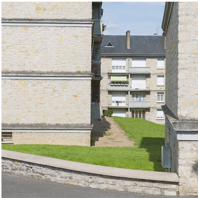
Façade latérale du bâtiment B et vue sur la façade postérieure du bâtiment C. 58, Nevers rue de Gonzague
