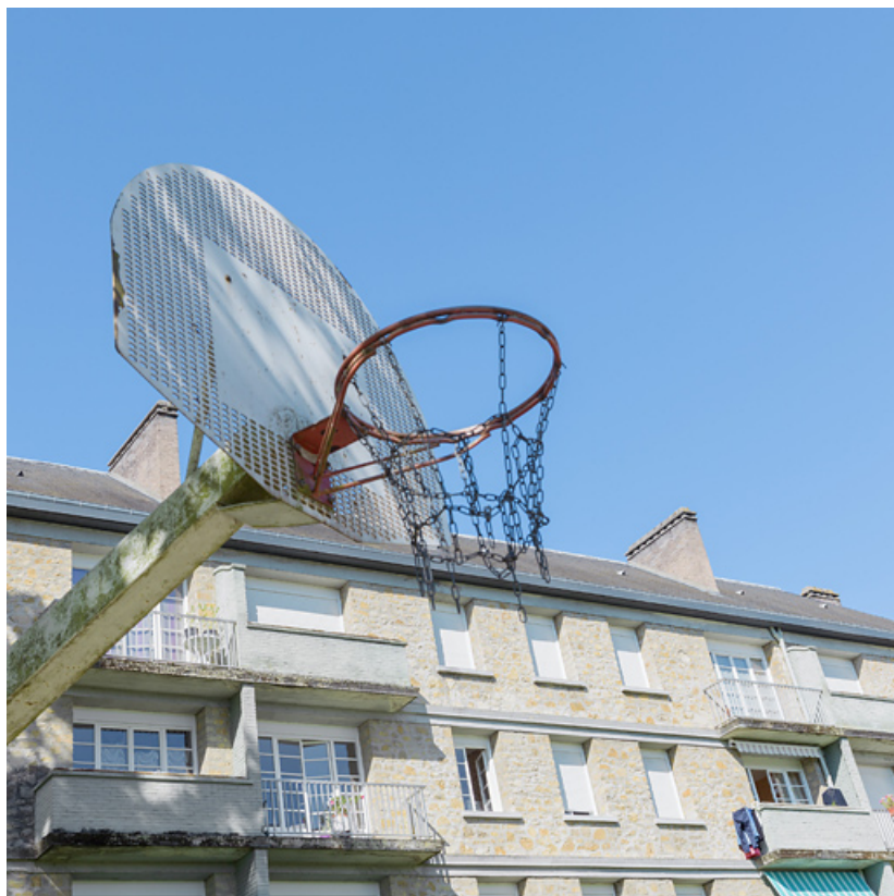
Façade postérieure du bâtiment A et mobilier urbain.
