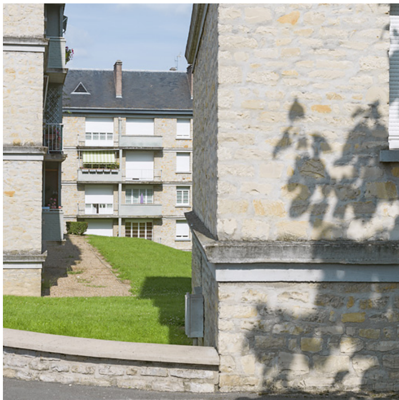
Bâtiment A et vue sur la façade postérieure du bâtiment C.
