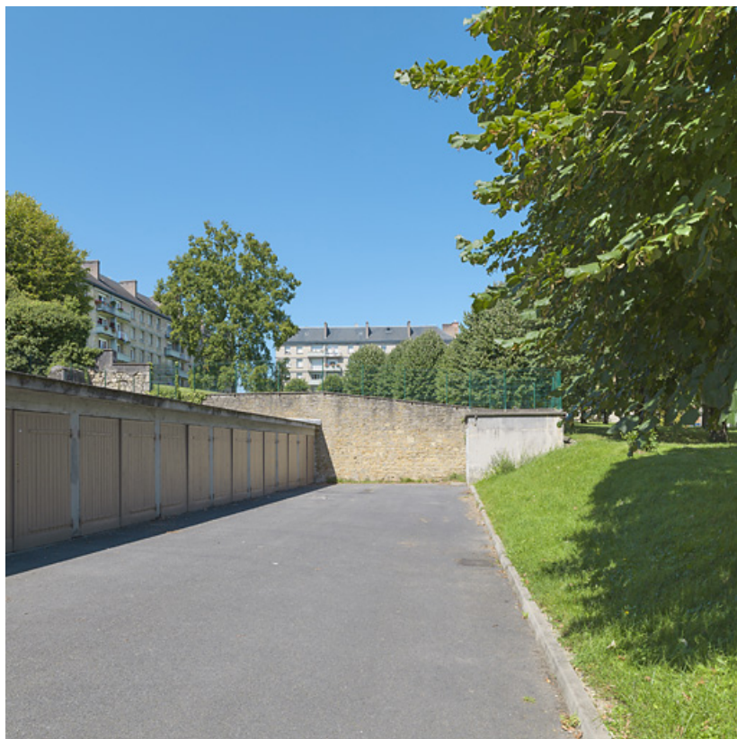
Vue depuis le square Edouard-Millien au sud.
