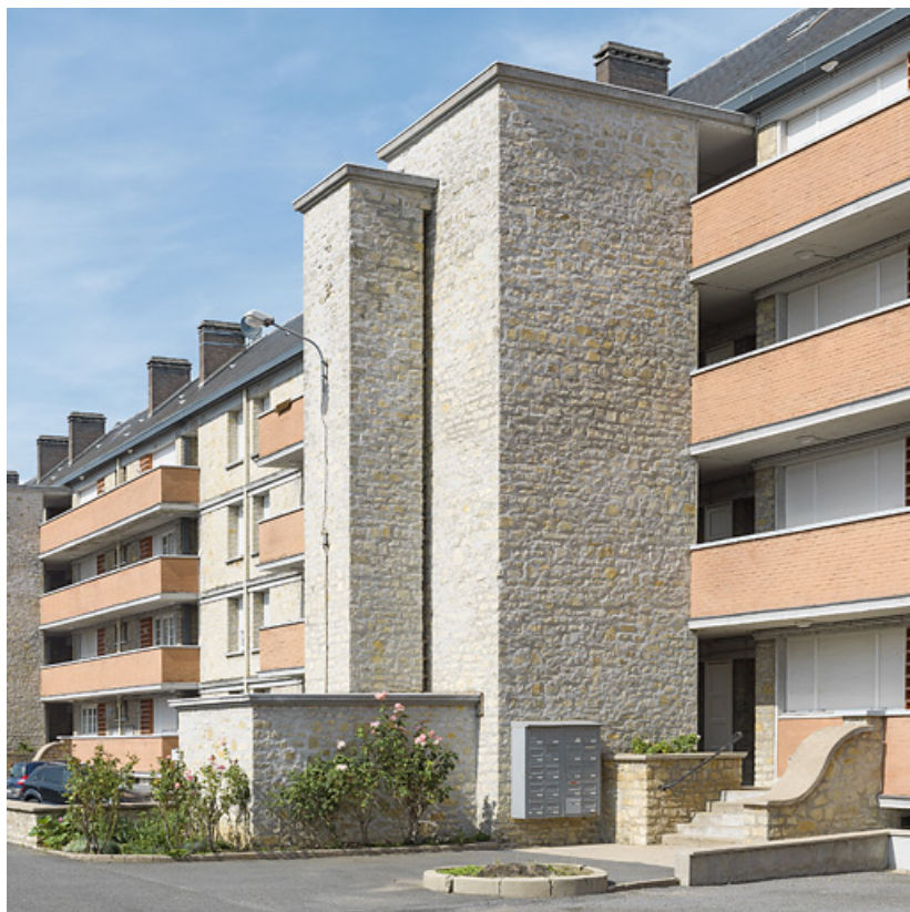
Façade antérieure du bâtiment A.
