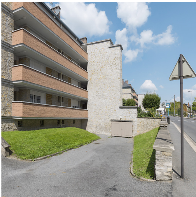
Bâtiment D : façade antérieure, rampe d'accès au sous-sol. 58, Nevers rue de Gonzague
