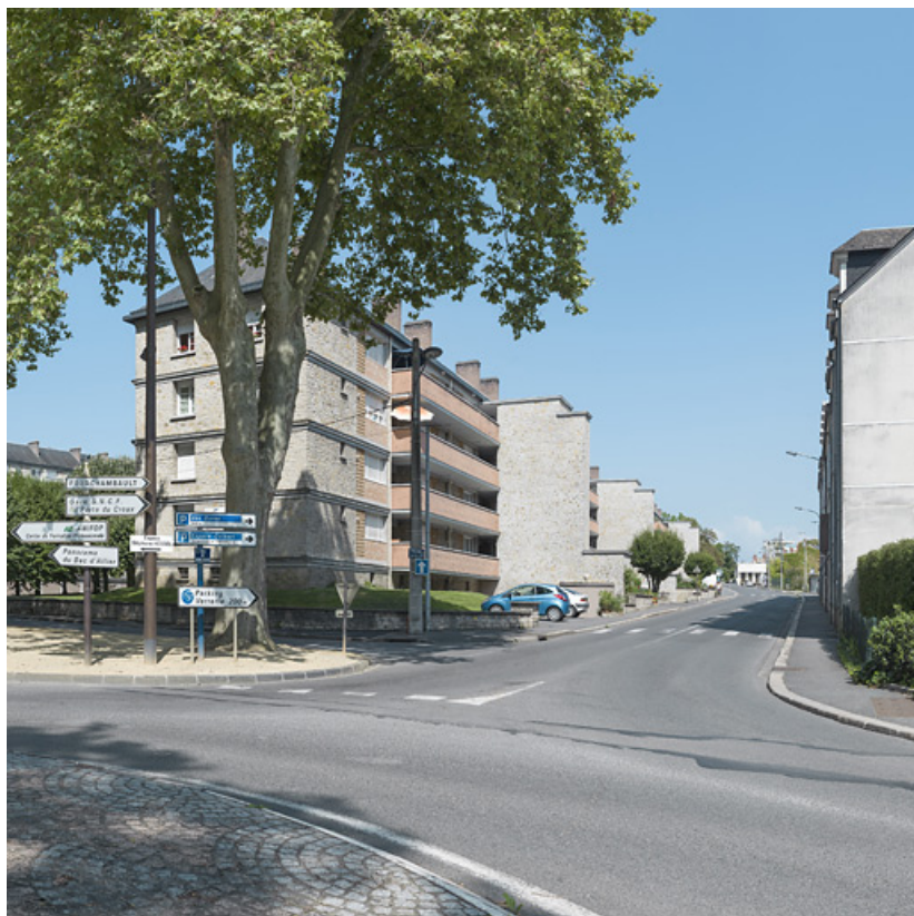
Bâtiment D : façades antérieure et latérale sud. 58, Nevers rue de Gonzague
