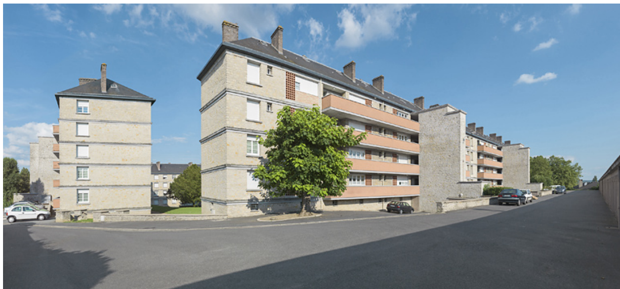
Façade antérieure du bâtiment A et façade latérale du bâtiment B. 58, Nevers rue de Gonzague
