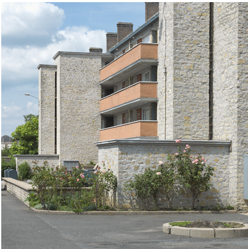
Façade antérieure du bâtiment A.
