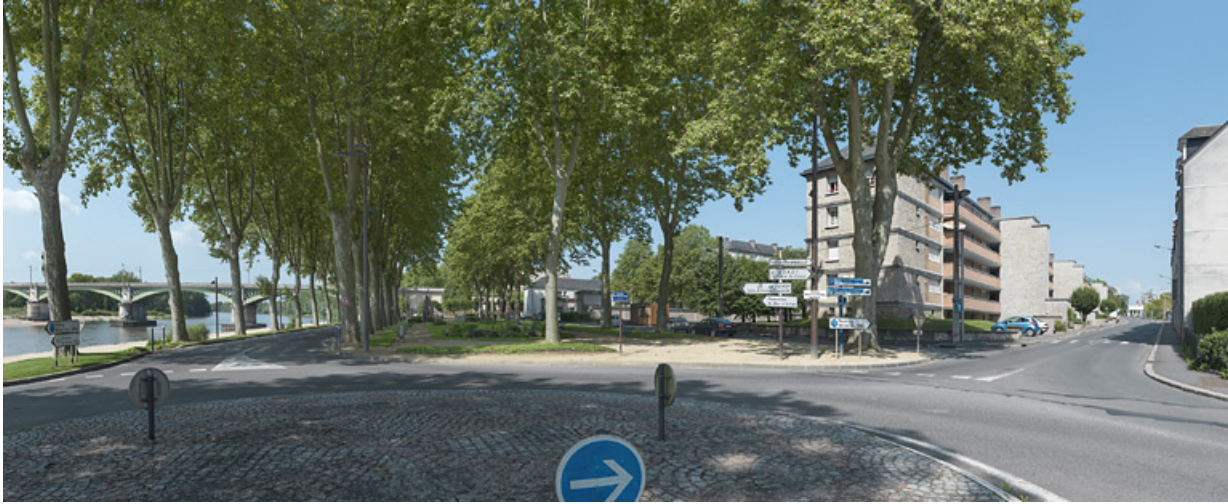
Bâtiment D : vue en situation depuis le sud.
