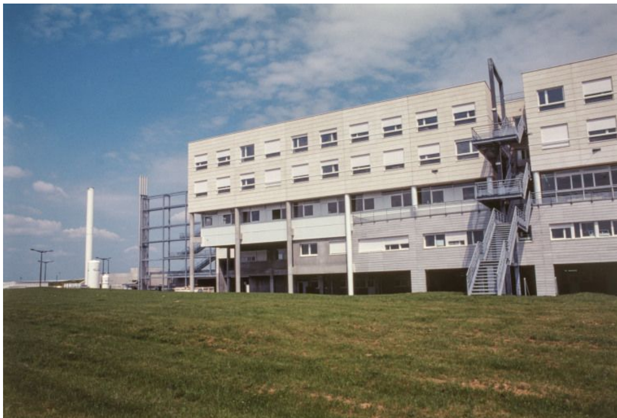
Façade postérieure, partie gauche.
