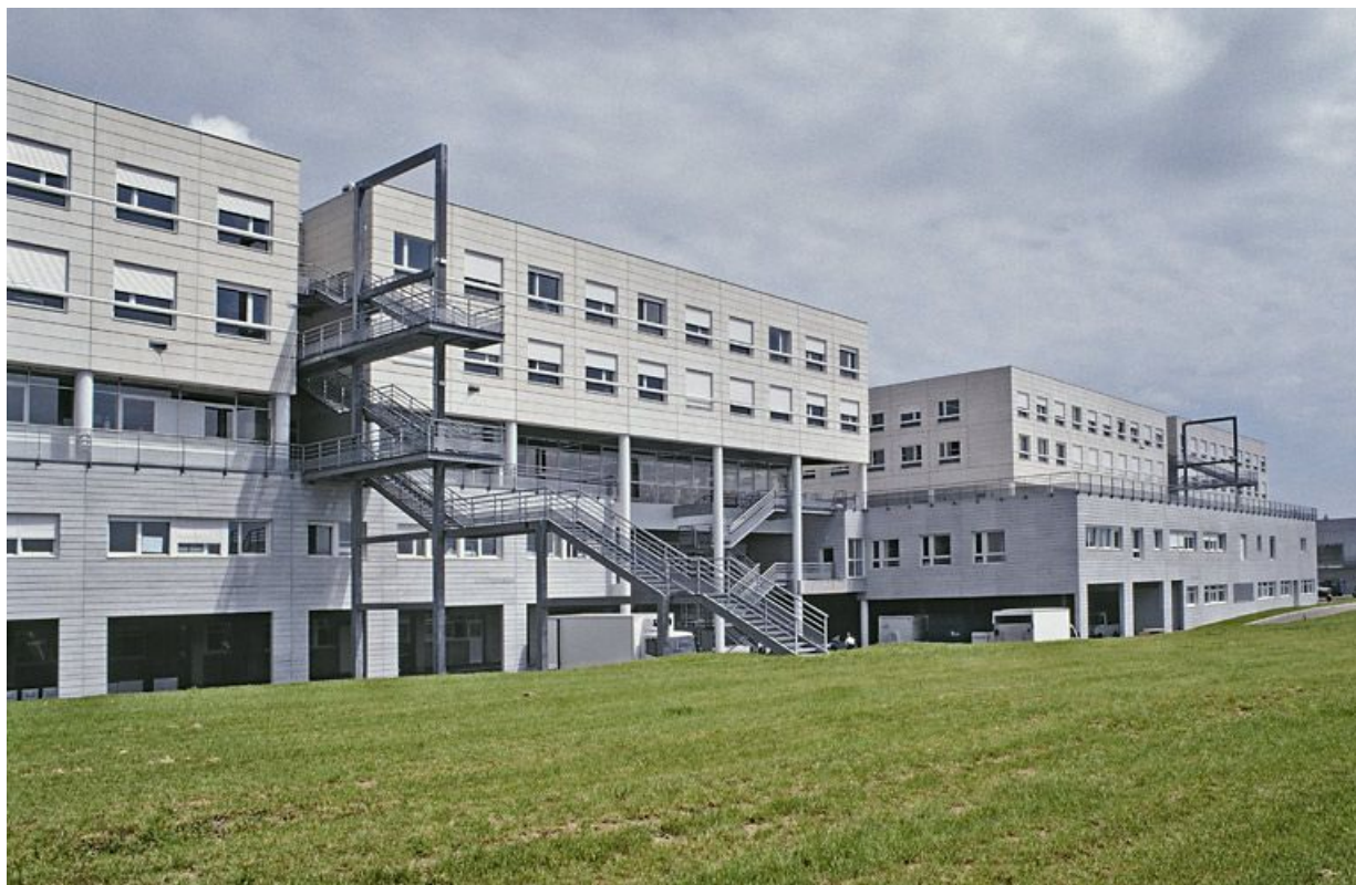
Façade postérieure, partie droite.
