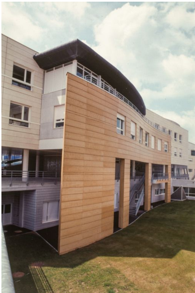
Façade antérieure, détail de la partie gauche.
