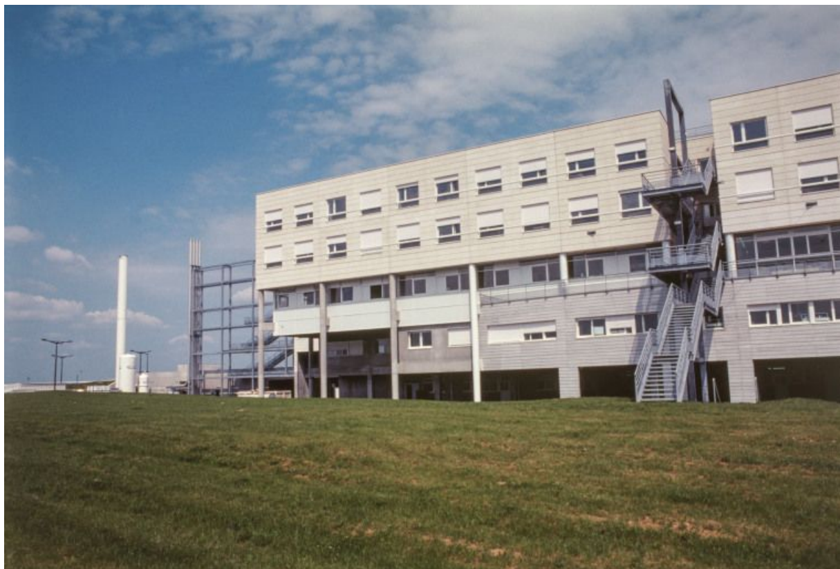
Façade postérieure, partie gauche.
