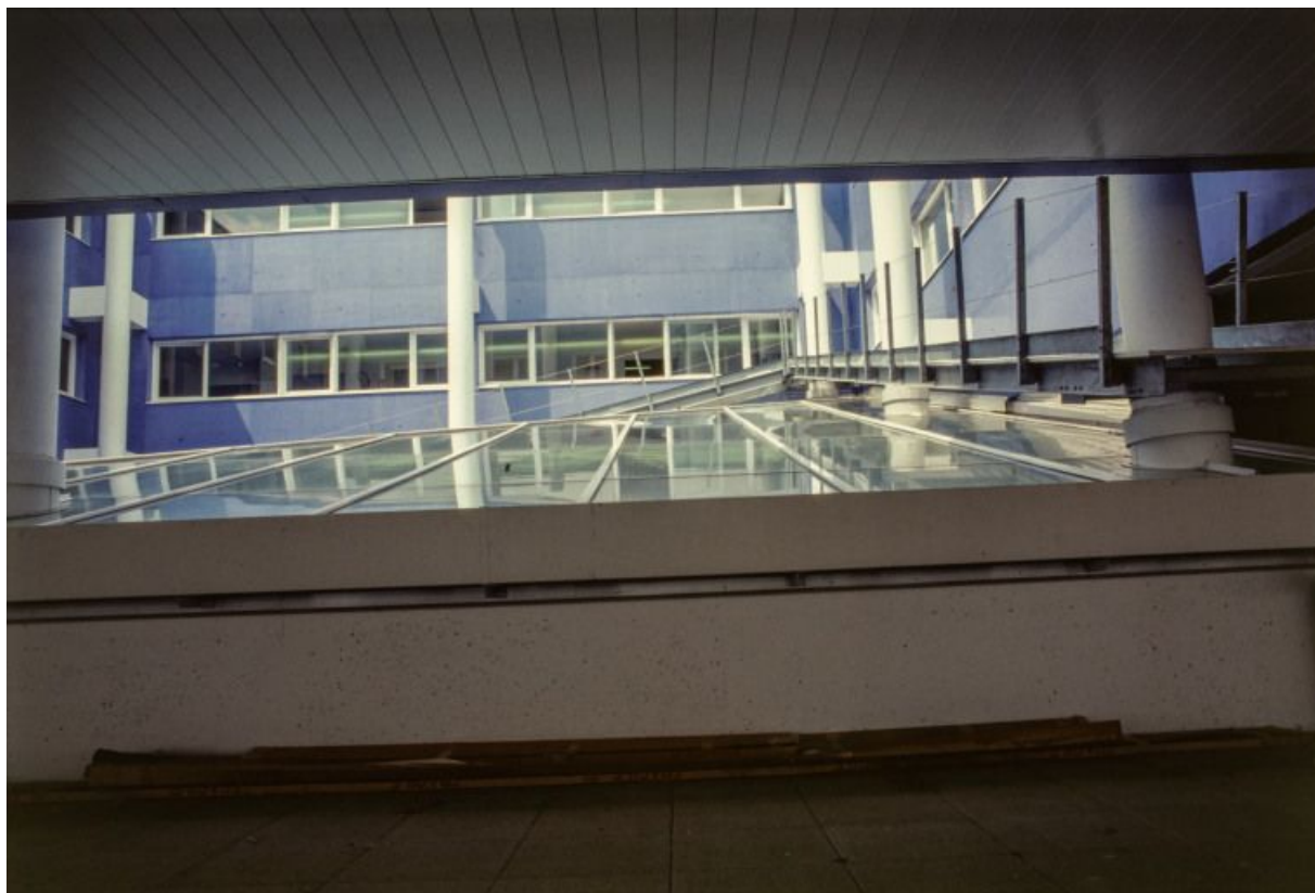
Vue du patio vers les salles d'opération.
