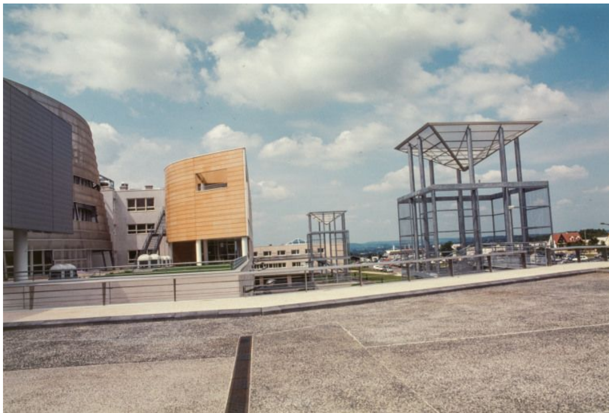
Façade postérieure, vue de la terrasse.
