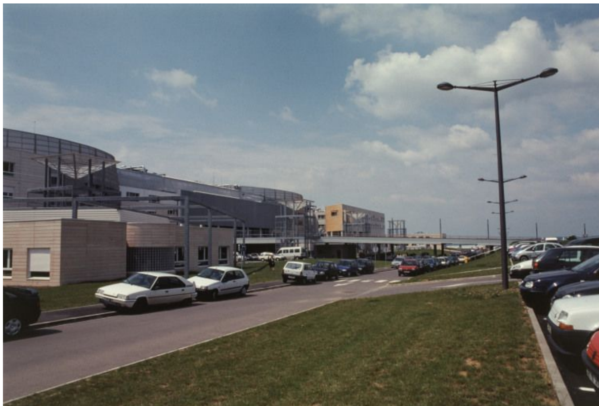
Façade antérieure, vue d'ensemble.
