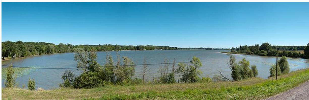
Vue d'ensemble de l'étang de Baye depuis la digue le séparant de celui de Vaux.
