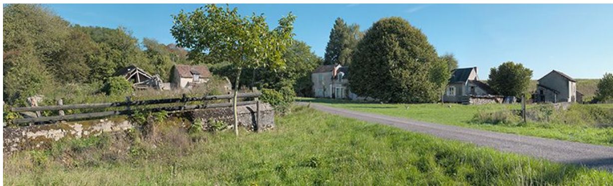
Vue d'ensemble du site avec les bâtiments. A droite, en contrebas, l'entrée du premier tunnel. 58, La Collancelle, lieudit : bief de partage
