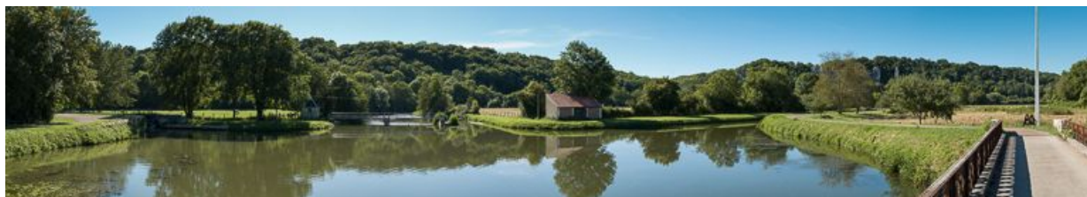
Vue panoramique de la râcle de Basseville : au centre le barrage et à droite, on aperçoit le site d'écluse 51. 58, Surgy, lieudit : bief 51 du versant Seine
