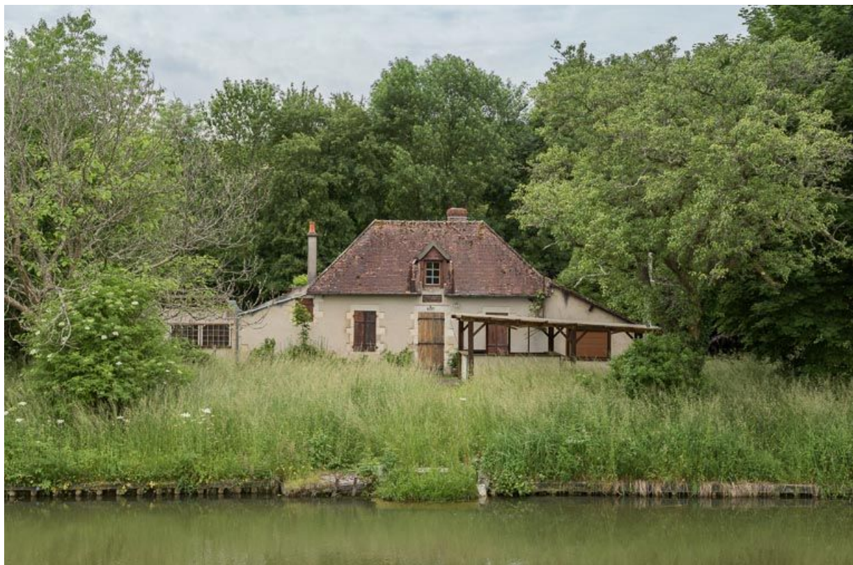
Vue de face de la maison éclusière, depuis la rive droite.
