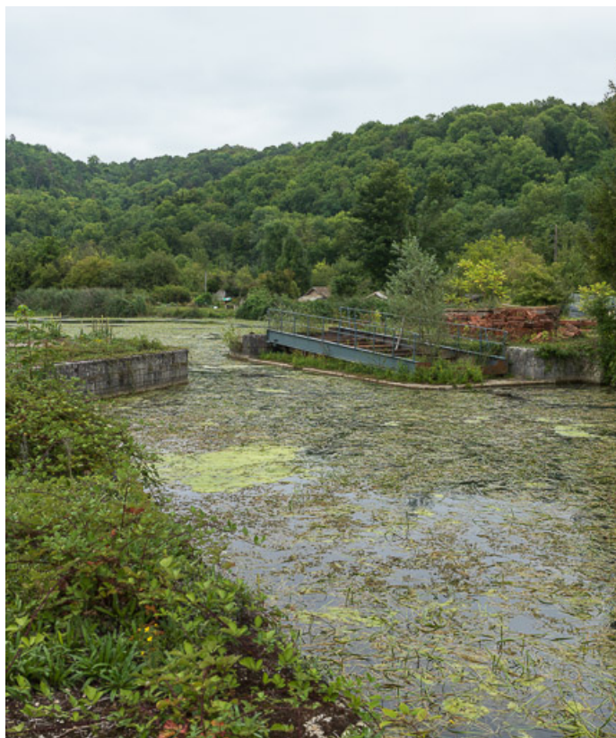
Vue du site, où subsiste l'ossature métallique du pont tournant.
